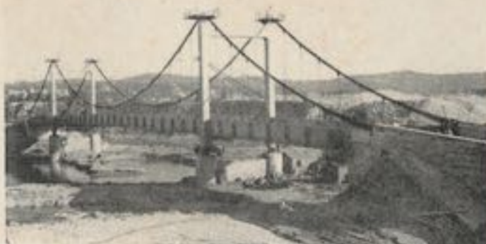
Fig. 12. — Pont de la R. N. 04 sur le canal de fuite.
