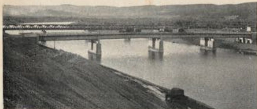
Fig. 10. — Pont-route et pont-rail franchissant le canal d'aménée.
