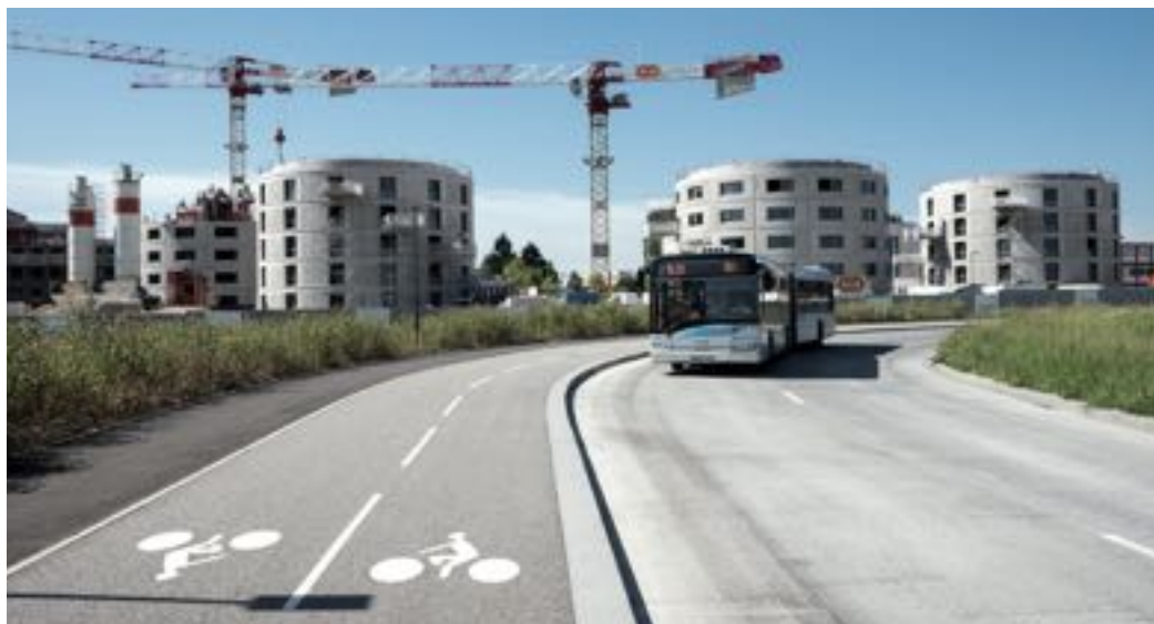
Les travaux liés au Grand Paris Express - ici à Saclay (Essonne) - contribuent à hauteur de 1% à la hausse de l'activité des travaux publics.
