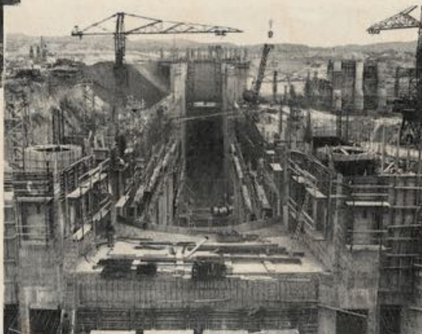
Fig. 22. — Chantier de l'écluse vu de l'amont.
