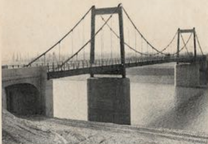
Fig. 11. — Pont de C. D. 53 sur le canal d'aménée.
