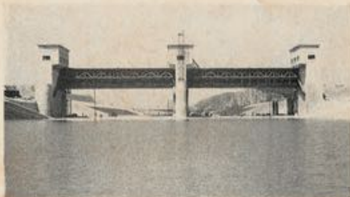
Fig. 9. — Barrage de garde navigable vu de l'aval. Les deux vannes sont levées.
