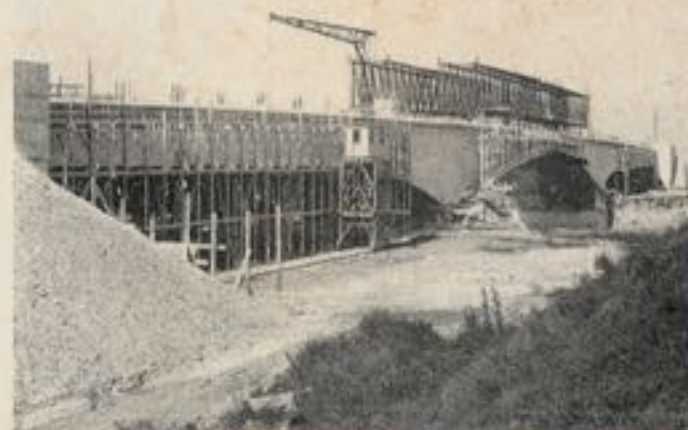
Fig. 13. — Pont de la R. N. 7 sur le canal de fuite en cours d'achèvement.
