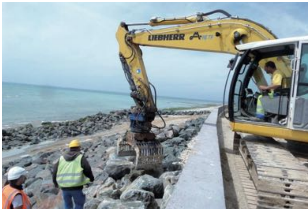
Les ouvriers de ce chantier ont été sensibilisés à l'environnement par le théâtre.
