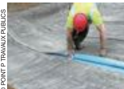
La géomembrane apporte étanchéité et résistance à la toile.
