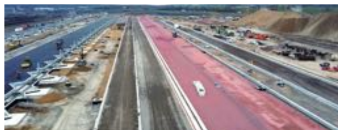
Les caniveaux occupent moins de surface qu'un bassin de rétention des eaux pluviales.
