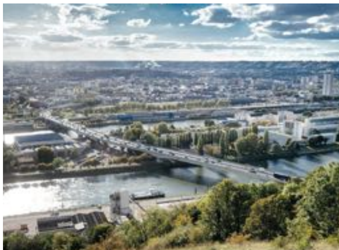
Les auteurs d'un article sur la réfection d'une travée, la 1 re à droite sur la photo, du pont Mathilde à Rouen (Seine-Maritime), ont reçu un prix.
