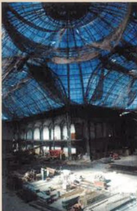
**Vue intérieure du Grand Palais. Ensemble aire de fabrication et stockage cages d'acier paroi**
