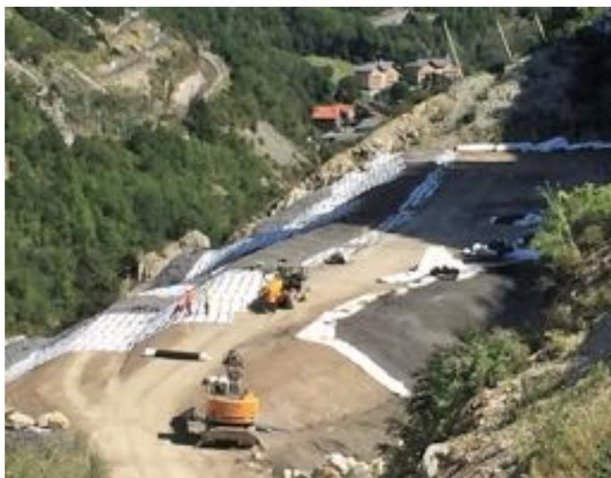
Plate-forme de stockage des déchets en cours d'encapsulation. Sur la pente, le géocomposite à barrières filtrantes de 13 cm de haut.
