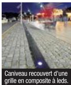
Caniveau recouvert d'une grille en composite à leds.
