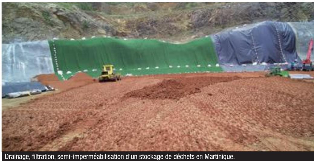
Drainage, filtration, semi-imperméabilisation d'un stockage de déchets en Martinique.
