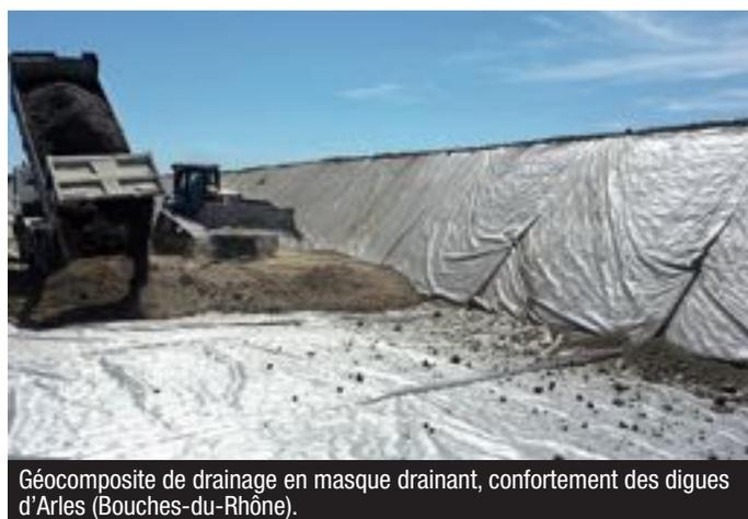
Géocomposite de drainage en masque drainant, confortement des digues d'Arles (Bouches-du-Rhône).
