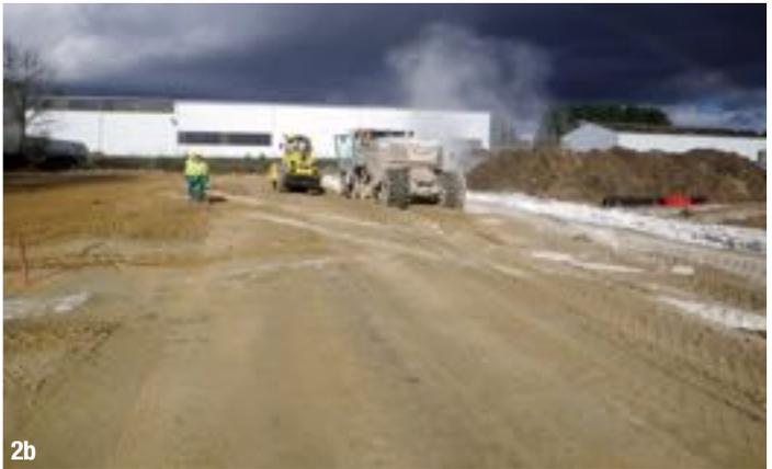
2a & 2b- Effet d'un traitement à la chaux sur un sol argileux humide (à gauche avant traitement, à droite après traitement).
