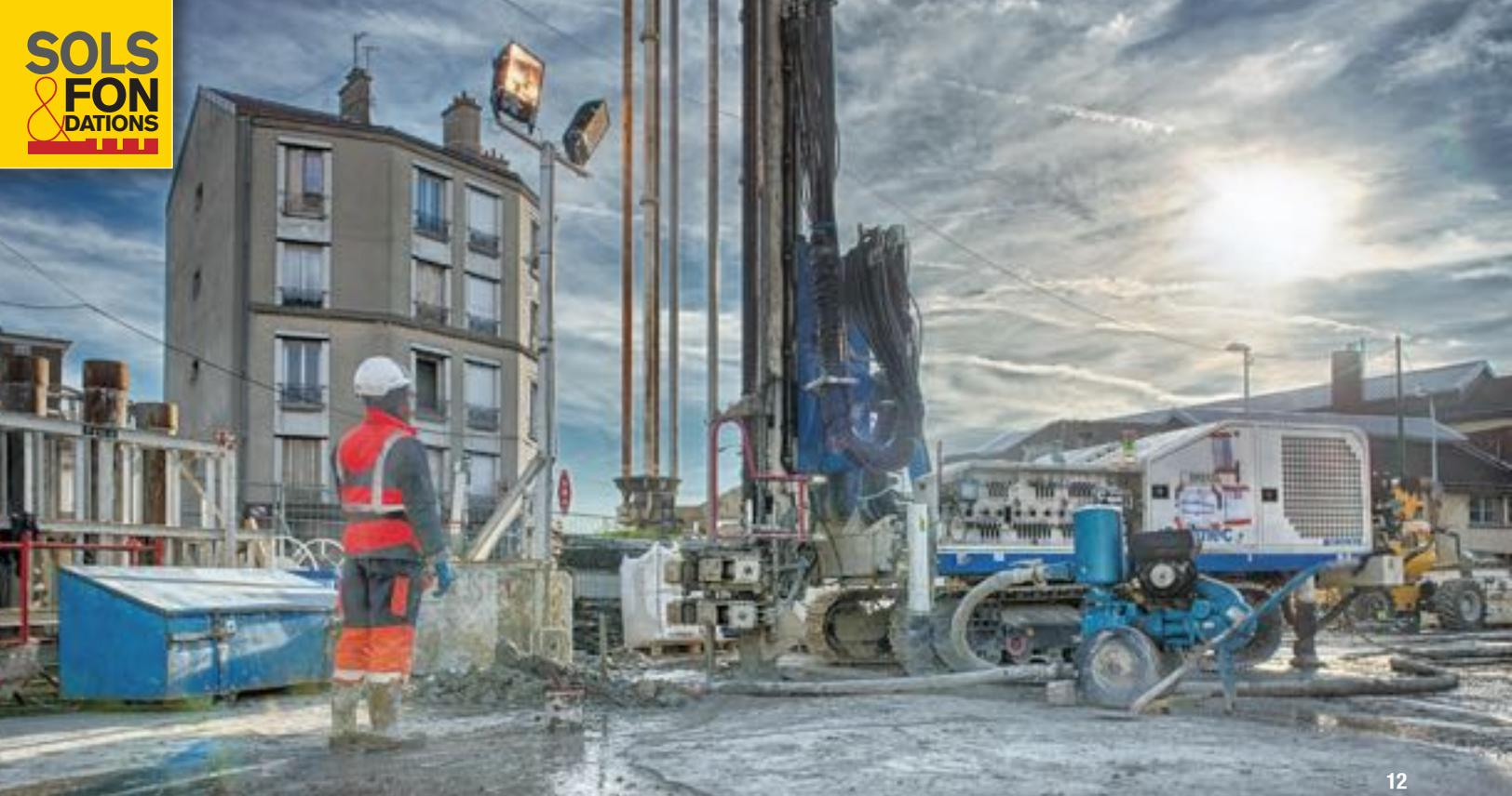
Pour compléter le volet environnemental du projet, un tiers des panneaux de paroi moulée de la station Mairie est équipé en géothermie. La prise en compte des contraintes thermiques dans le calcul du ferrailage est à ce titre un exercice intéressant.
