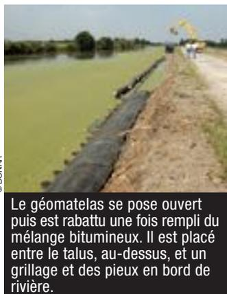
Le géomatelas se pose ouvert puis est rabattu une fois rempli du mélange bitumineux. Il est placé entre le talus, au-dessus, et un grillage et des pieux en bord de rivière.
