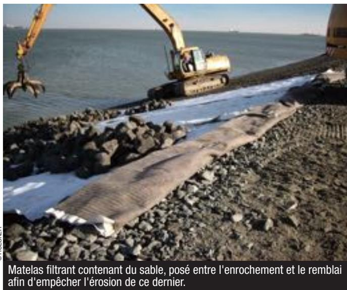
Matelas filtrant contenant du sable, posé entre l'enrochement et le remblai afin d'empêcher l'érosion de ce dernier.
