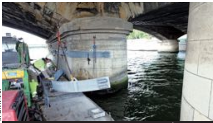
Cerclage des piles en maçonnerie avant forage des micropieux. À l'arrière-plan, la deuxième ligne de piles d'un élargissement du pont.
