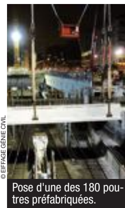
© EIFFAGE GÉNIE CIVIL
