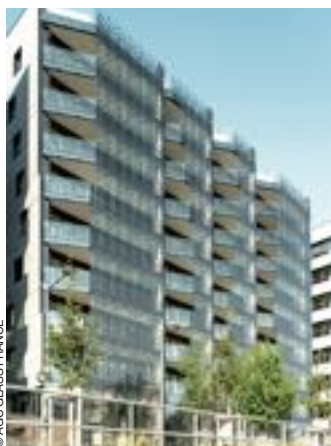
Les garde-corps des balcons sont constitués de deux verres abritant une couche de cellules photovoltaïques.
