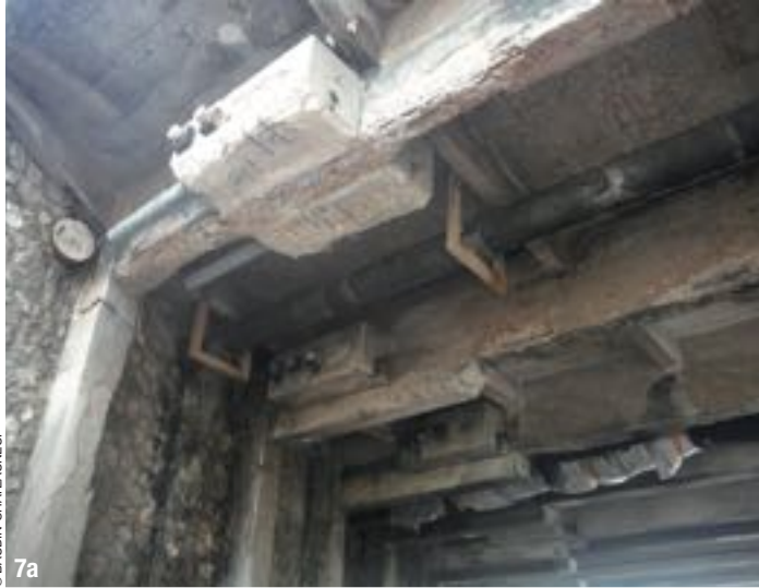
7a- Massif d'ancrage et poutres côté culée Nord - vue avant travaux. 7b- Massif d'ancrage et poutres côté culée Nord - vue après travaux. 8- Massif d'ancrage de la poutre 64 Nord après travaux.
