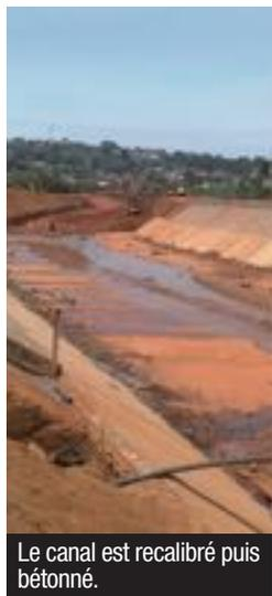
Le canal est recalibré puis bétonné.
