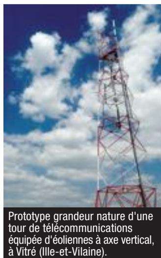
Prototype grandeur nature d'une tour de télécommunications équipée d'éoliennes à axe vertical, à Vitré (Ille-et-Vilaine).
