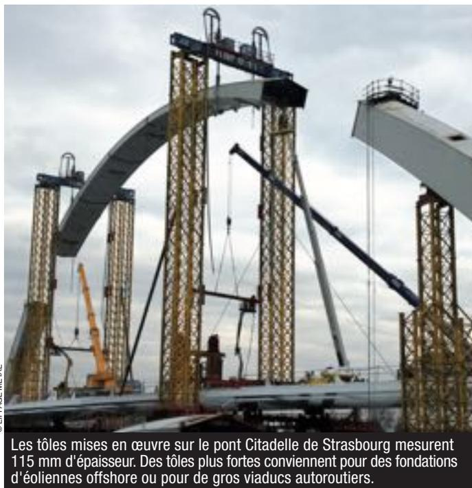
Les tôles mises en œuvre sur le pont Citadelle de Strasbourg mesurent 115 mm d'épaisseur. Des tôles plus fortes conviennent pour des fondations d'éoliennes offshore ou pour de gros viaducs autoroutiers.
