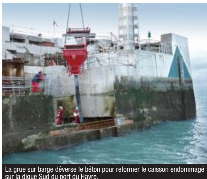
La grue sur barge déverse le béton pour reformer le caisson endommagé sur la digue Sud du port du Havre.
