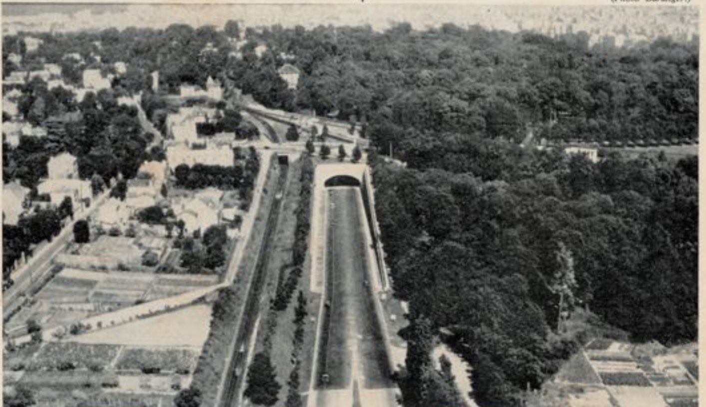
Fig. 4. — Vue aérienne de la sortie ouest du tunnel de Saint-Cloud. (Photo Baranger.)
