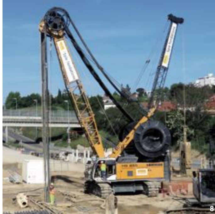
8- TC de Saint-Jérôme - vue de la rotforeuse et de la benne à câble.
