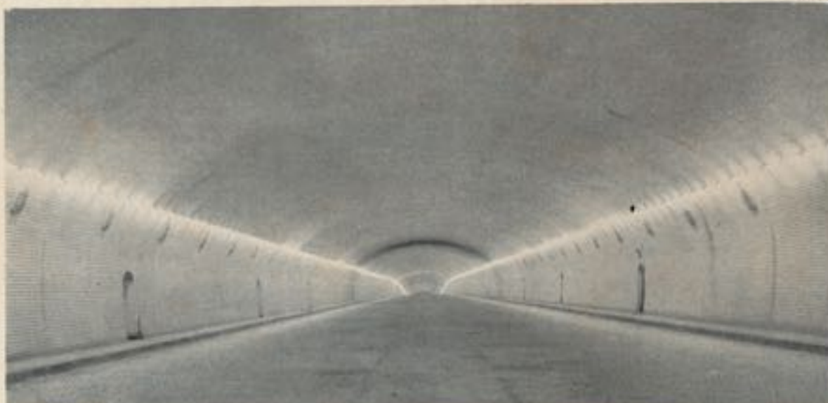
Fig. 12. — Eclairage normal utilisant l'ensemble des circuits A, B et C. Les paralumes ont été déposés pour nettoyage.
