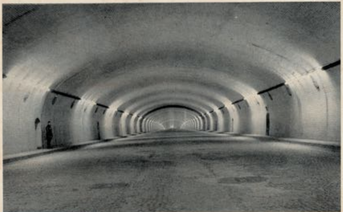
Fig. 12. — Eclairage normal utilisant l'ensemble des circuits A, B et C. Les paralumes ont été déposés pour nettoyage.
