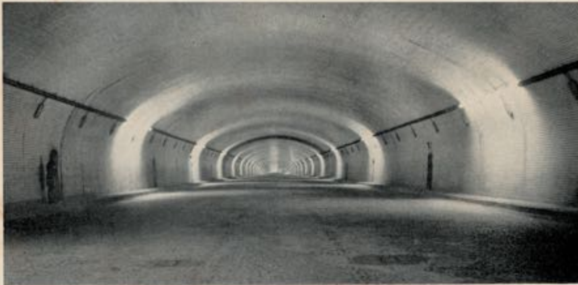
↑ Fig. 10. — Eclairage réduit utilisant le régime A.
