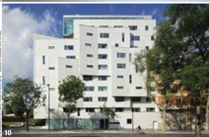
© JACQUES RIPAUT ARCHITECTURE - MÉDIATHÈQUE LAFARGE
