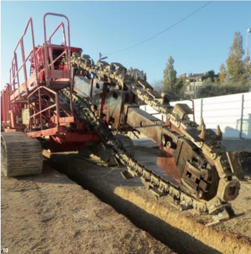
lisé selon le procédé Trenchmix® (voir encadré - figure 10) armé (inclusion de profilés IPE 360 de 9 m de hauteur fichés dans le terrain) par voie humide. Le coulis, mélangé dans un bac de reprise, était en l'occurrence poussé jusqu'à la trancheuse par l'intermédiaire d'une pompe hydraulique à piston, réglable via un système de radio-commande proportionnel. ▷
