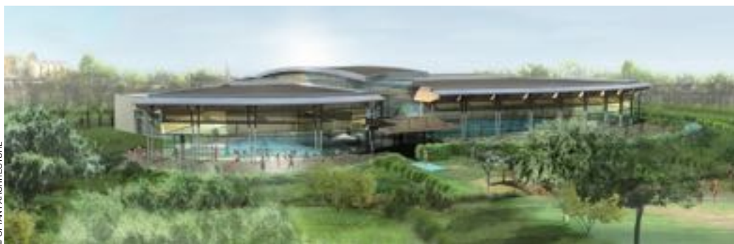
La loi demande que les énergies renouvelables couvrent 38 % de la consommation finale de chaleur en 2030. Vue du centre nautique de la Communauté de communes du Bonnevalais (Eure-et-Loir) où un captage géothermique à 30 m de profondeur associé à une pompe à chaleur chauffera l'air et maintiendra les bassins en température, à partir de septembre 2016.
