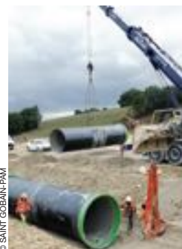
Plus de 30 km ont été posés, parfois sous remblais de 18 m de haut.
