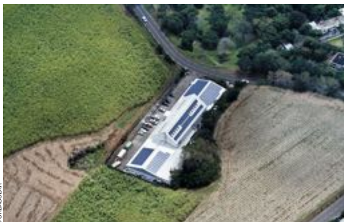
Un appel d'offres sur le solaire photovoltaïque est ouvert pour les départements d'Outre-mer. Ici, capteurs sur les toits de la Sofarem à Sainte-Marie (La Réunion).
