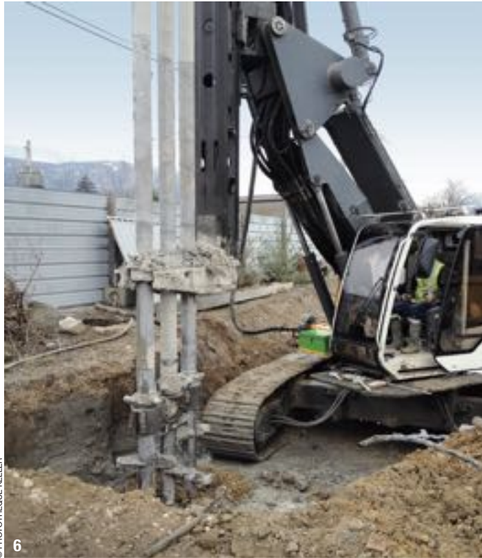
6- Vue de la foreuse avec triple outil en début de forage. 7- Mise en place d'un fer avec la foreuse. 8- Vue de la plateforme re-terrassée.
