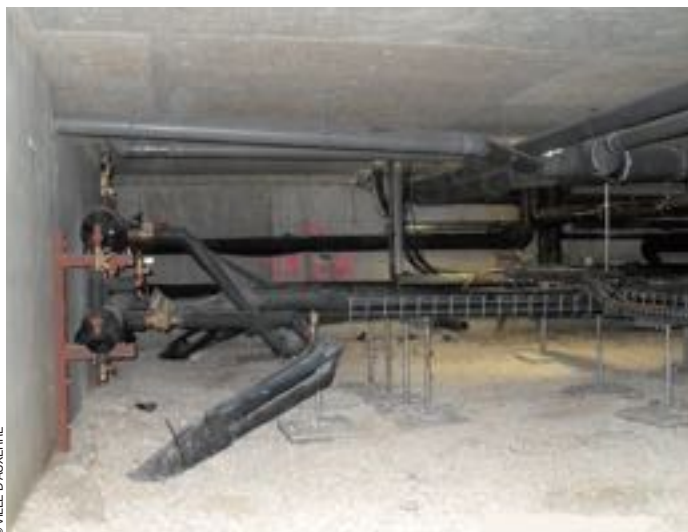
Récupération de chaleur du sous-sol à Auxerre (Yonne) : raccordement de pieux géothermiques au circuit climatique d'une salle de spectacles.
