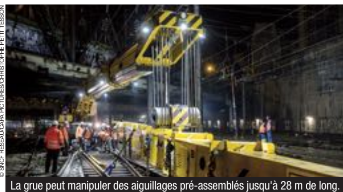
La grue peut manipuler des aiguillages pré-assemblés jusqu'à 28 m de long.
