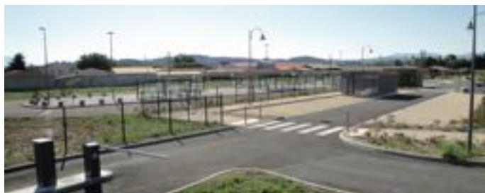
Les collectivités territoriales auront accès à des prêts à taux 0. Ici, pôle d'échanges de transports à Aix-en-Provence inauguré par le Conseil général des Bouches-du-Rhône en 2014.
