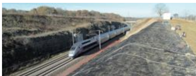
1 er prix du concours photos des Rencontres géosynthétiques 2015, catégorie protection et sécurisation de notre environnement : sécurisation d'une voie ferrée à Massilly (Saône-et-Loire).
