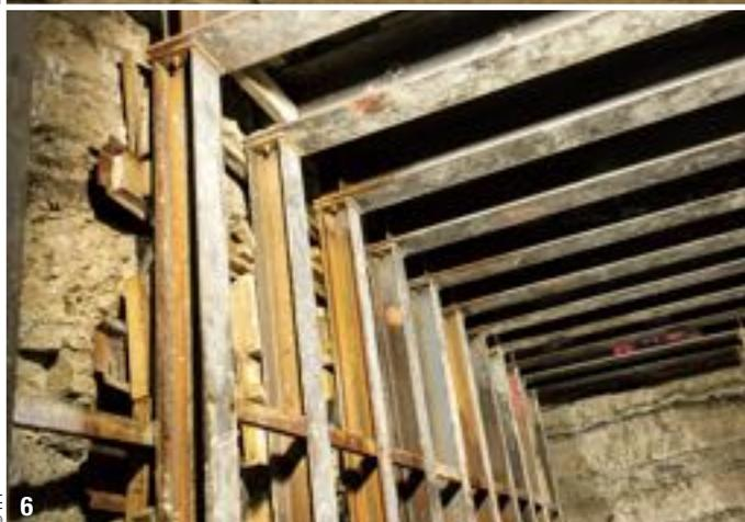
une réflexion importante a été menée sur l'ordre de mise en œuvre des barres dans cet environnement extrêmement réduit avec l'interaction des poteaux de blindage au milieu des ferrillages. (figure 9).
