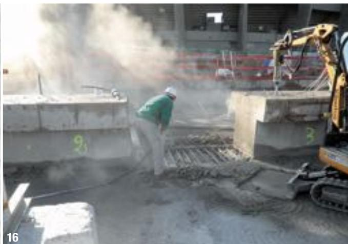
lition de la dalle haute, reconstruction de la dalle haute, démolition de la partie supérieure des poutres). Elles ont permis de définir des seuils d'alerte et de vigilance pour chacune des poutres. En complément du suivi des déformations des poutres par les extensomètres, un suivi topographique de l'ensemble de la structure a été réalisé.
