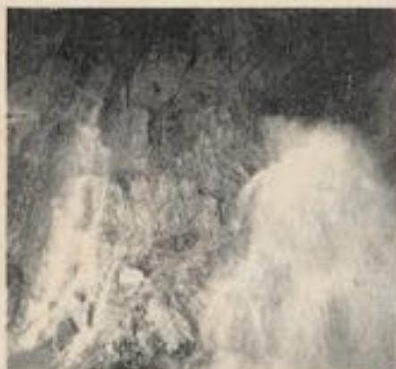
Fig. 9. — Le tunnel inondé par une nappe d'eau de 0,4 m, après la venue d'eau.
