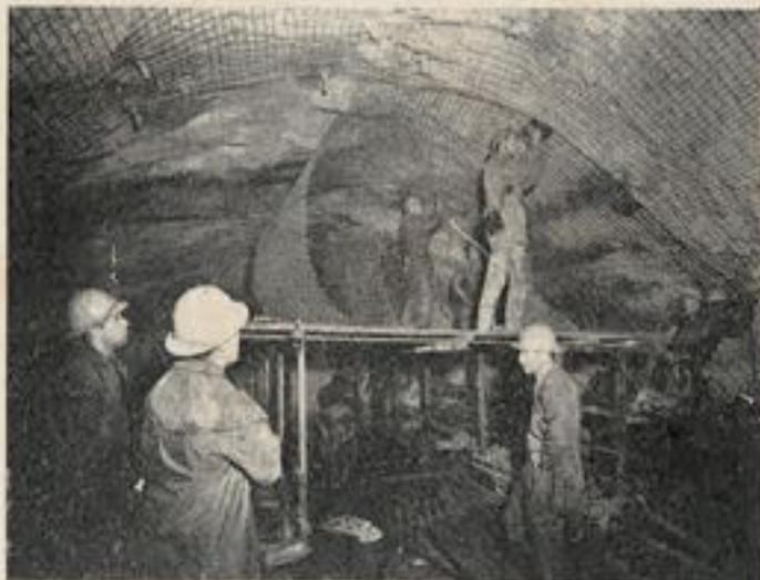
la violence avec laquelle il se produit. Les « coups de terrain » se manifestent sur le versant italien du tunnel du Mont-Blanc, à partir du P. K. 1304, par des explosions soudaines, vraiment terrifiantes, et accompagnées de la projection inopinée de blocs ou de plaques de roche, soit du front, soit des piédroits, soit du ciel de la galerie.
