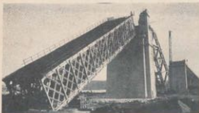
Fig. 19. — Destruction de la travée d'accès de 51 m.
