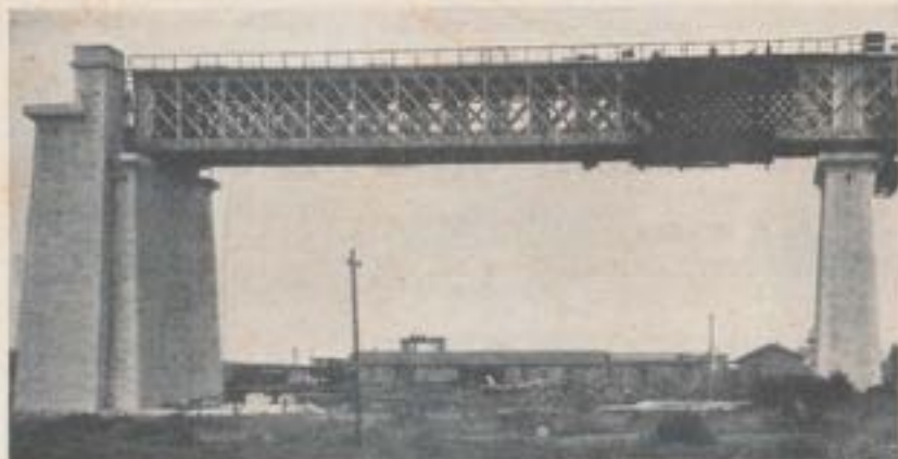
Fig. 23. — Travée d'accès après réparation.
