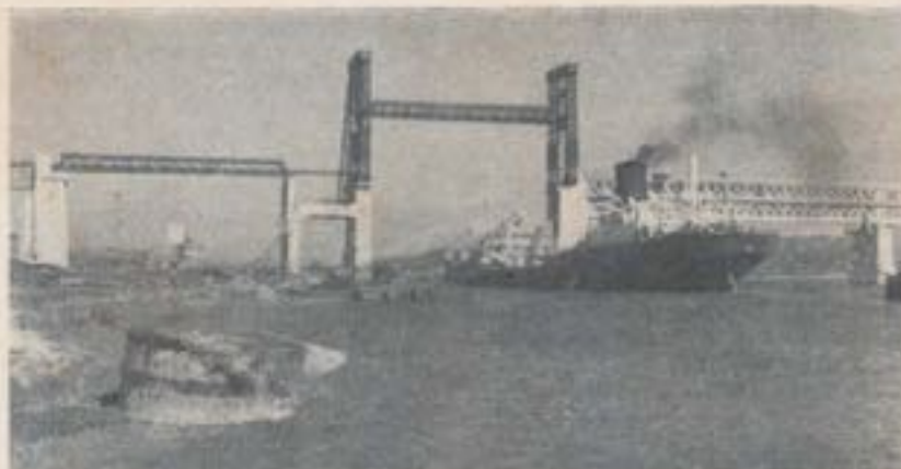
Fig. 25. — Passage d'un bateau sous la travée levante.
