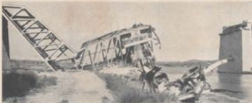
Fig. 13. — Travée tournante : destruction.
