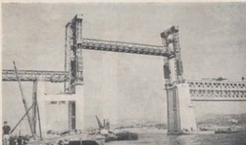
Fig. 17. — Premier levage de la travée levante.
