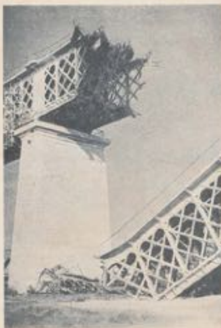
Fig. 20. — Coupure de la travée de 51 m. : détail.
