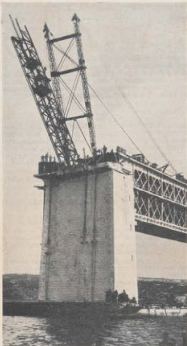
Fig. 15. — Montage des pylônes métalliques.
