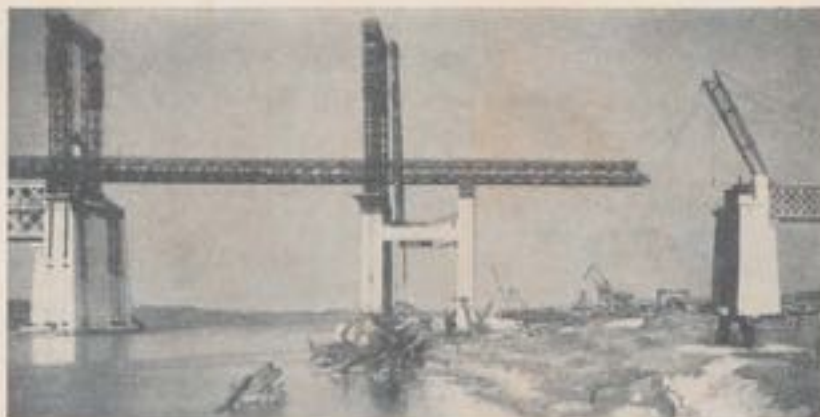
Fig. 16. — Lancement du pont provisoire.
