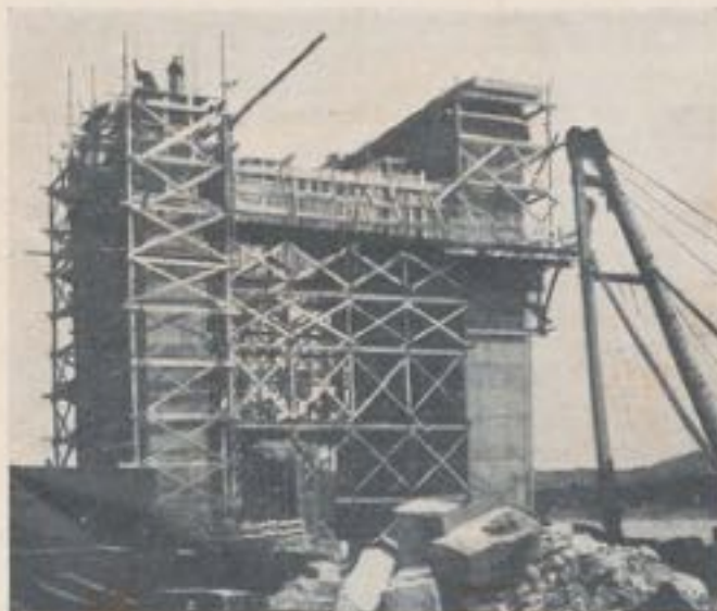
Fig. 14. — Construction de portique en béton armé.
