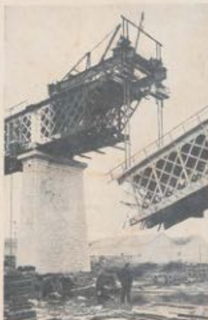
← Fig. 21. — Relevage de la travée d'accès
