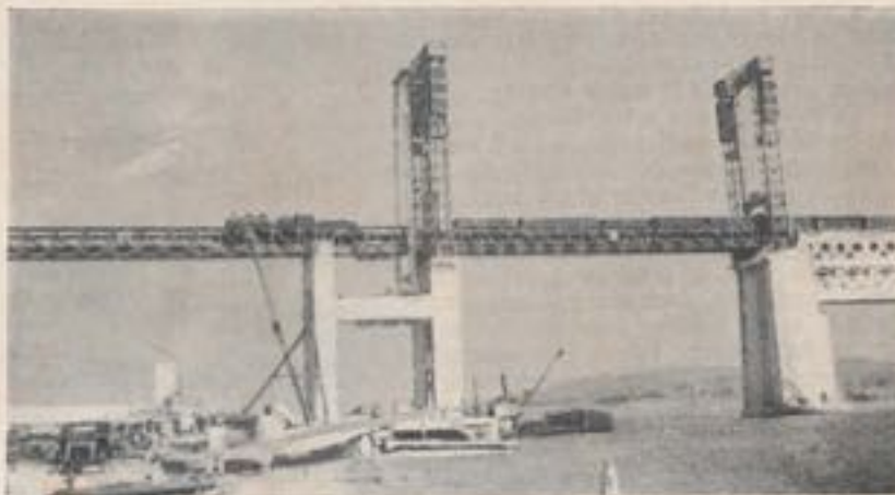
Fig. 18. — Vue d'ensemble du pont provisoire.
