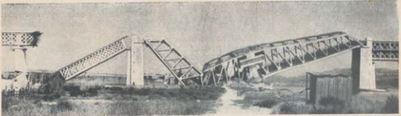
Fig. 3. — Le viaduc après sa destruction.
