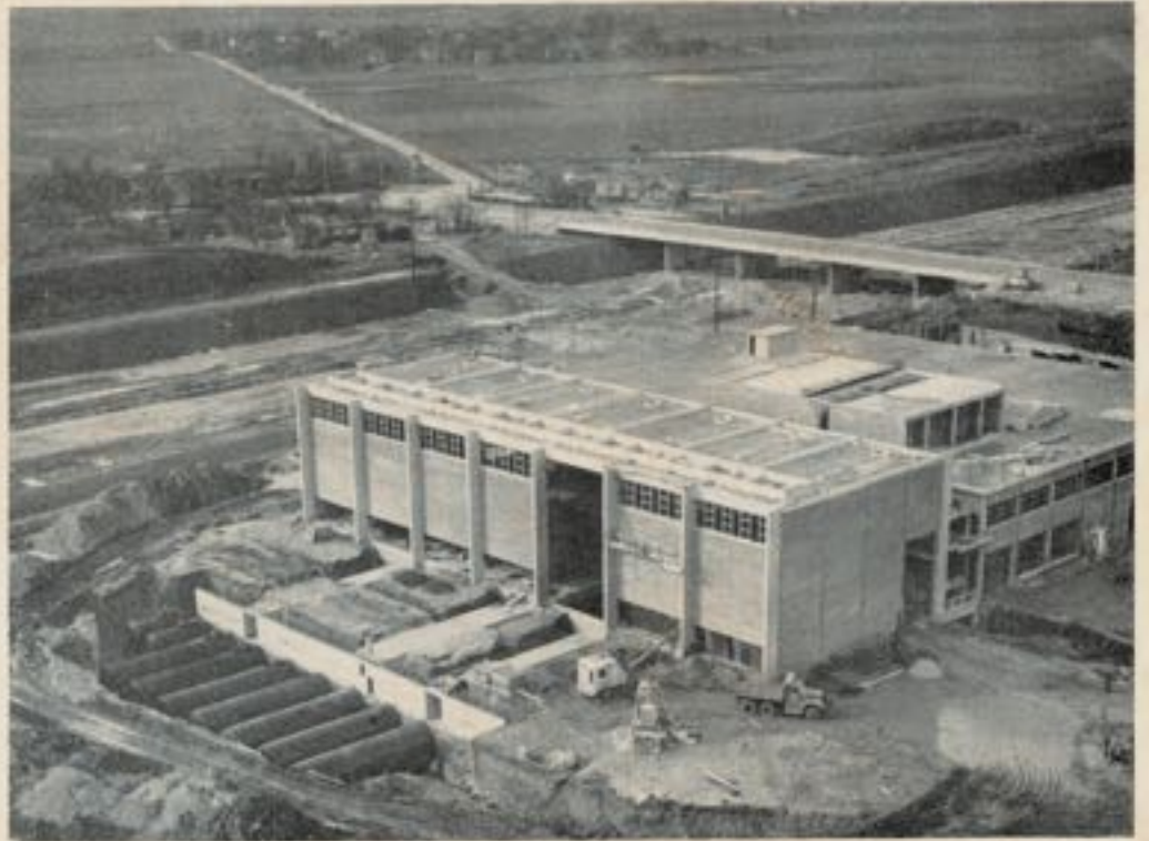
→ Fig. 6. — Vue de la centrale thermo- électrique, en cours de construction (10-2-58).
