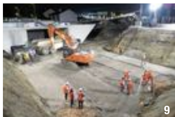
9- Préparation du fond de fouille pour ripage.
