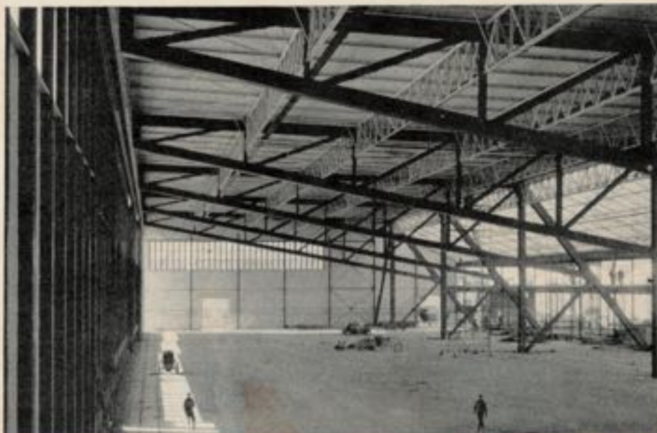
Fig. 8. — Vue intérieure du hangar n° 5.
