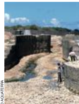
Les panneaux des gabions sont constitués de barres plastifiées.
