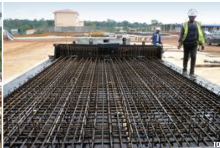
9- Soudure en cours sur l'ouvrage. 10- Préfabrication foraine des prédalles. 11- Prédalles en cours de pose.
