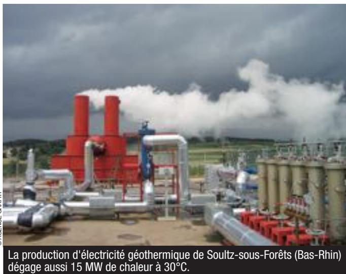
La production d'électricité géothermique de Soultz-sous-Forêts (Bas-Rhin) dégage aussi 15 MW de chaleur à 30°C.
