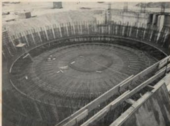
Fig. 6 Vue vers le Nord-Est, bâtiment réacteur tranche 2, ferrillage du radier
