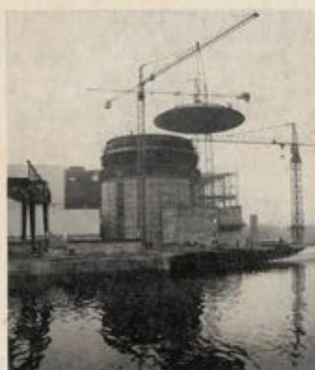
Fig. 8 Levage du dôme métallique préfabriqué, bâtiment réacteur, tranchée 2.
