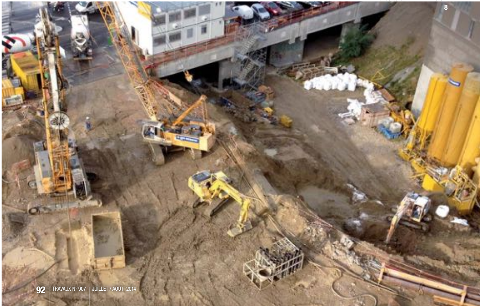
© BOUYGUES BÂTIMENT HABITAT SOCIAL
