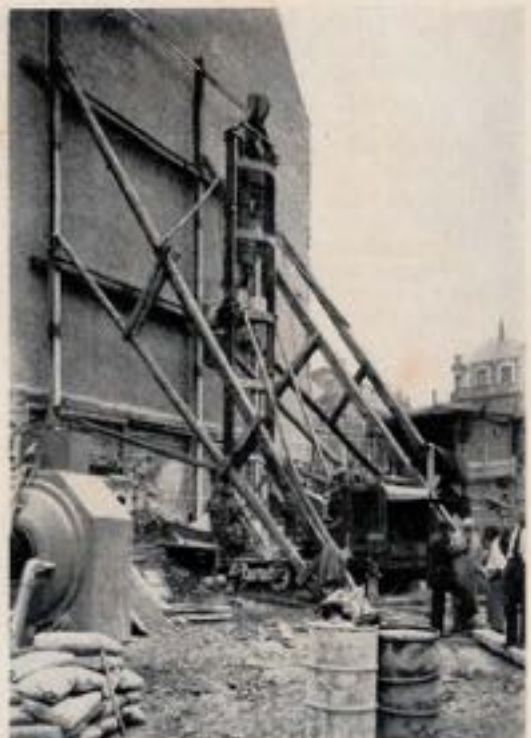
FIG. 5. Nouvelle machine de forage « Benoto » 1955, type E.D.F. (état du slope 10° de déplacement « Otario »).
