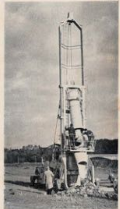
FIG. 3. — Nouvelle machine de forage « Benoto » 1954, type E.D.F. (en travail).
