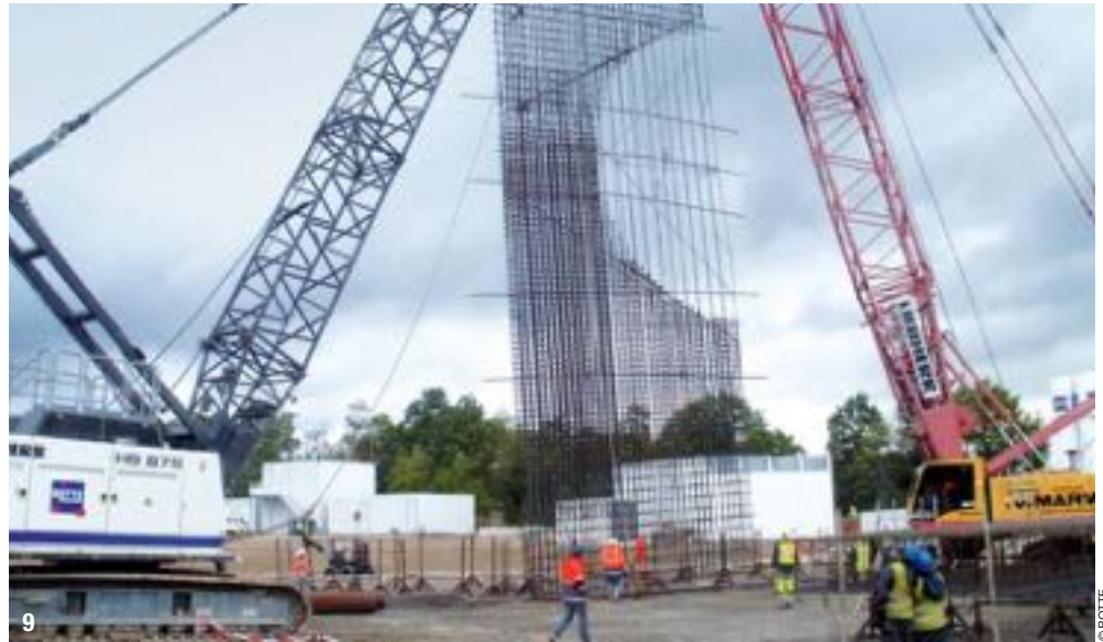
9- Cage d'armatures avec empreinte de passage du tunnelier.
