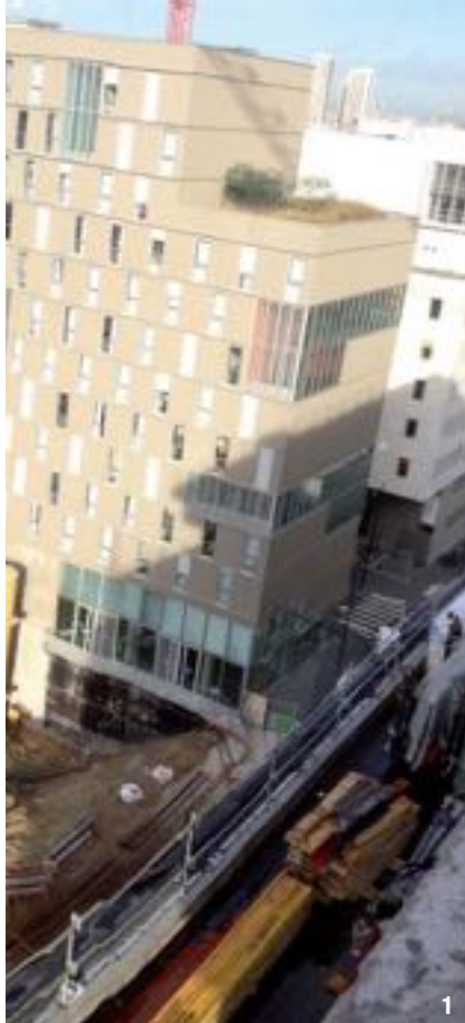
© BOUYGUES BÂTIMENT HABITAT SOCIAL
