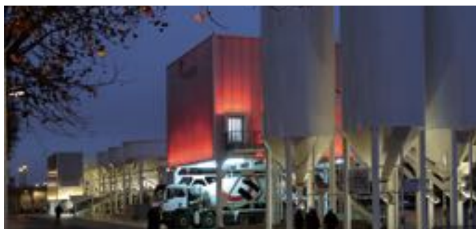
Holcim dispose de 138 centrales à béton en France. Ici, celle de Tolbiac à Paris.
