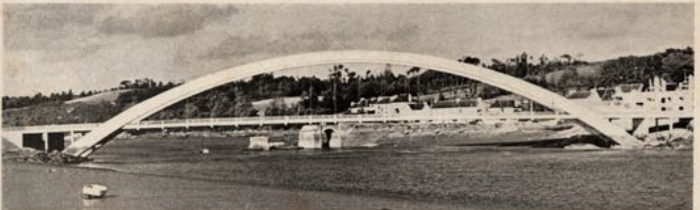
Fig. 1. — Élévation amont de l'ouvrage.
