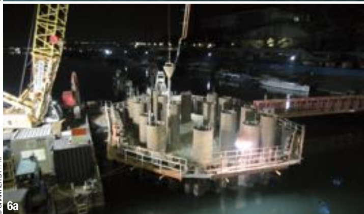
© CHANTIER BYTPRF 6a
