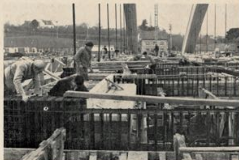
Fig. 11. — Ferrailage des pièces de pont. (Décembre 1953.)
