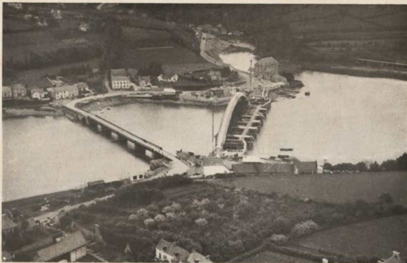
Fig. 2. — Vue aérienne montrant l'amélioration du tracé de la R. N. 786.
