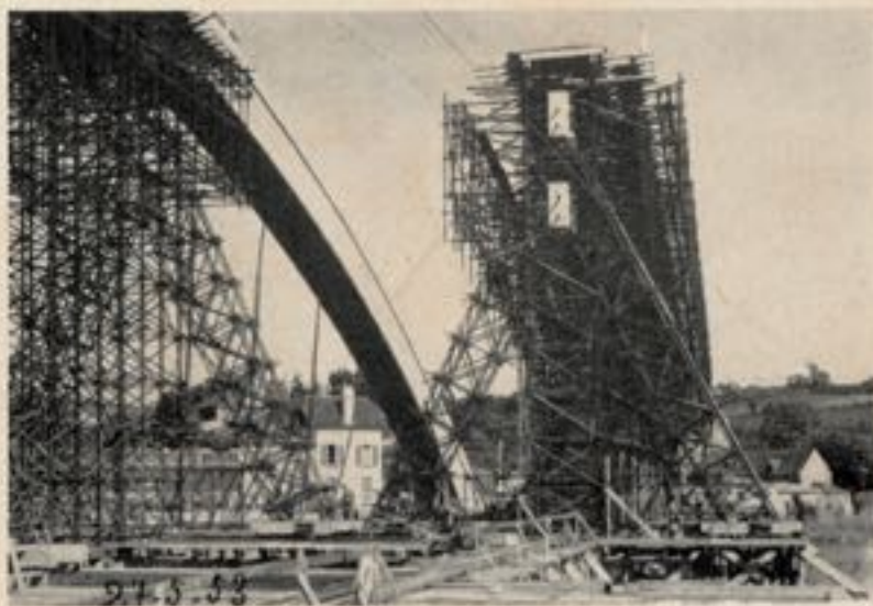
Fig. 18. — Ripage de l'échafaudage tubulaire (27-5-53). Remarquer les nœuds et patins en B. A. (Photo Studio Janvier.)
