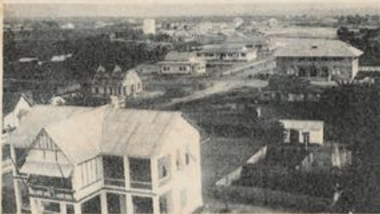
Vue de Pointe-Noire avec château d'eau.
