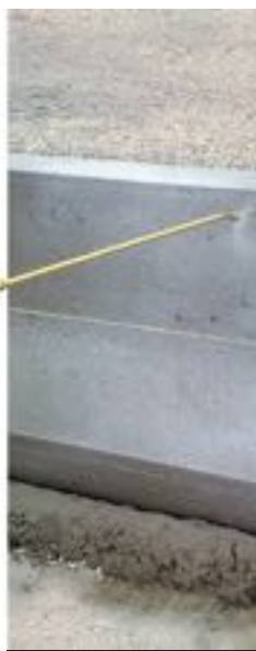
Le Easy Cure s'applique par pulvérisateur sur le béton à traiter.
