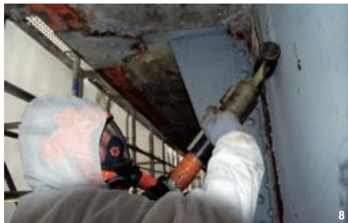
8- Décapage par induction des peintures contenant du plomb.
