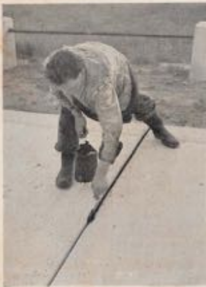
Fig. 17. — Garnissage des joints. Badigeonnage des parois des dalles.
