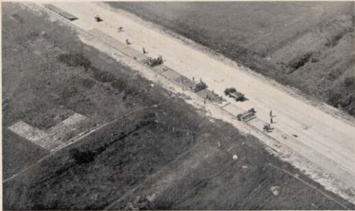
FIG. 11. — Branche sud. Vue aérienne du chantier de bétonnage alimenté par la centrale de Rocquencourt.
