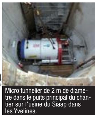
Micro tunnelier de 2 m de diamètre dans le puits principal du chantier sur l'usine du Siaap dans les Yvelines.
