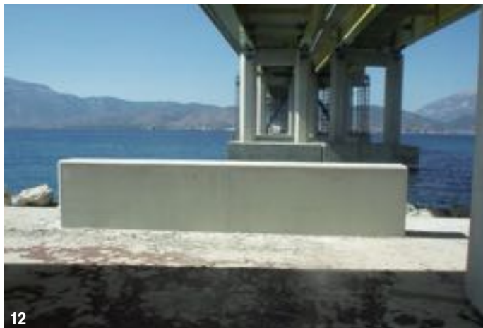
12- Mur sacrificiel du Pont de Rion-Antirion.
