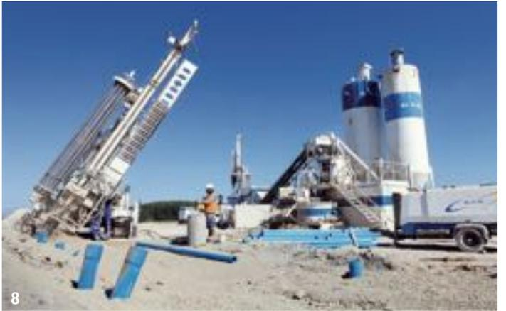
**7- Traitement des zones compressibles par la mise en œuvre de drains et d'inclusions rigides.**
