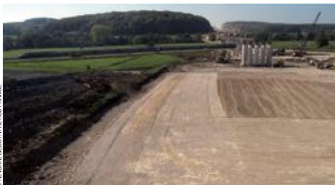
Renforcement par géosynthétique du remblai d'accès à un viaduc sur le projet de ligne à grande vitesse en Moselle.
