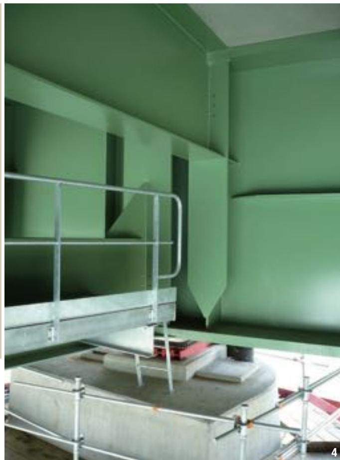
3 & 4- Entretoise d'appui biaisée entre pièces de pont droites (pile P4).
