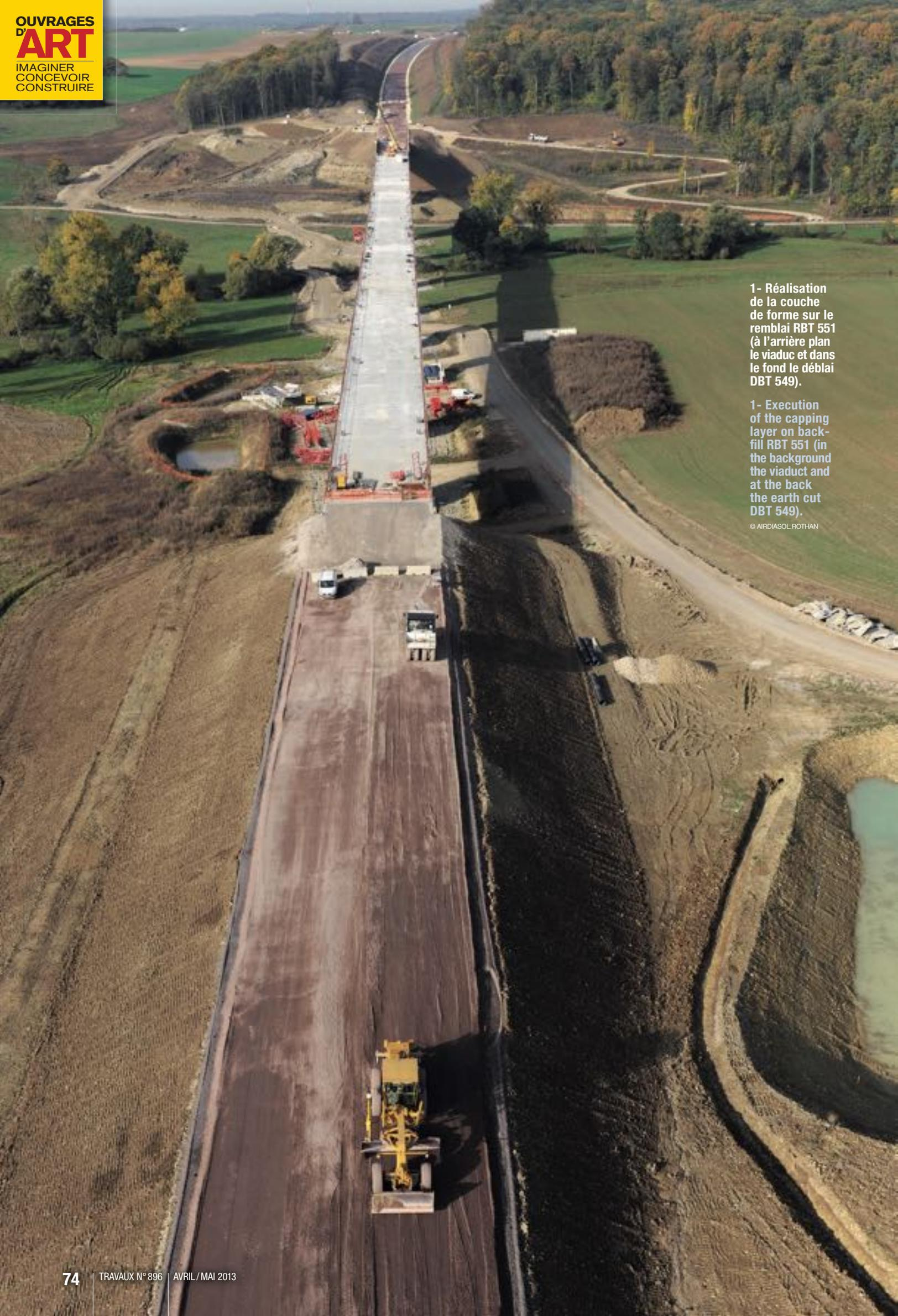
1- Réalisation de la couche de forme sur le remblai RBT 551 (à l'arrière plan le viaduc et dans le fond le déblai DBT 549).
