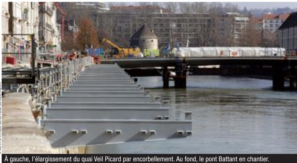
À gauche, l'élargissement du quai Veil Picard par encorbellement. Au fond, le pont Battant en chantier.
