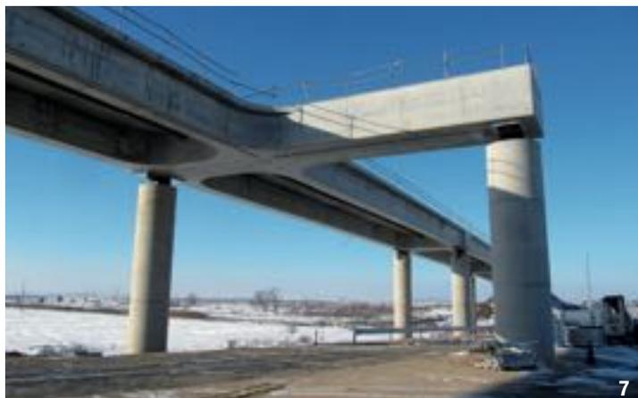
**7- Vue du bipoutre ferroviaire avec un portique et ses appareils d'appuis néoprènes.**
