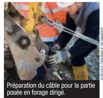
Préparation du câble pour la partie posée en forage dirigé.
