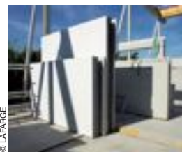
Ce double mur inclut de l'isolant et un vide rempli de béton sur chantier.
