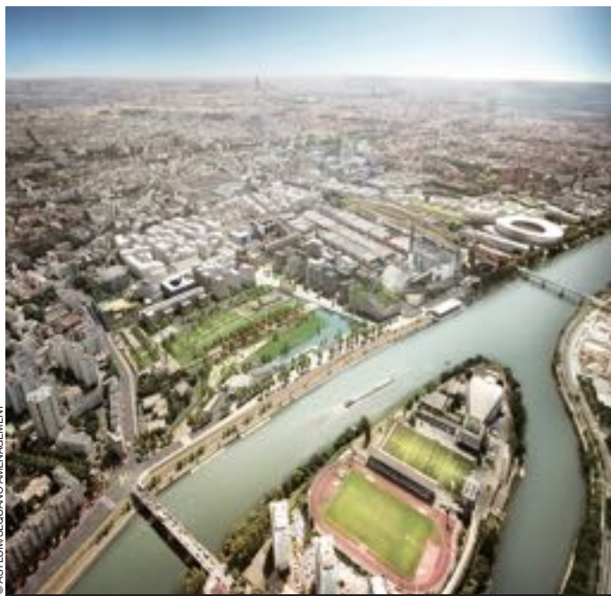
Le futur écoquartier des Docks de Saint-Ouen (Seine-Saint-Denis) longe la Seine sur laquelle il prélève des calories pour un tiers des besoins de son réseau de chaleur.
