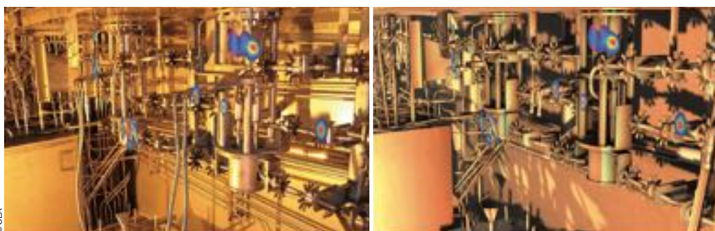
À gauche, relevé de points chauds par caméra gamma dans une installation nucléaire du CEA de Marcoule (Gard) et, à droite, simulation de ces relevés en 3D.
