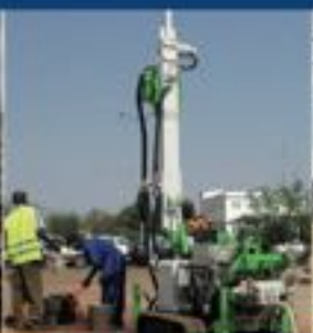
Travaux de sondages > MALL, TCHAD
