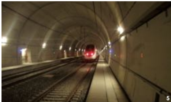
5- Train arrêté dans le tunnel de Chavanne pour la réalisation des essais radio INPT.
