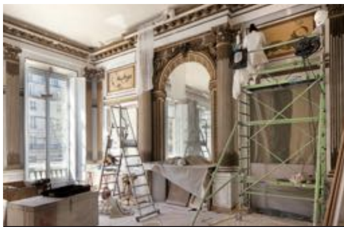
Vue du Grand salon en cours de restauration. Hauteur sous plafond : 5,40 m.
