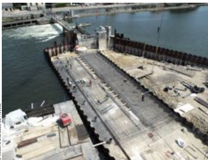
Ferraillage du radier du barrage de Villeneuve-sur-Yonne qui date de 1860.
