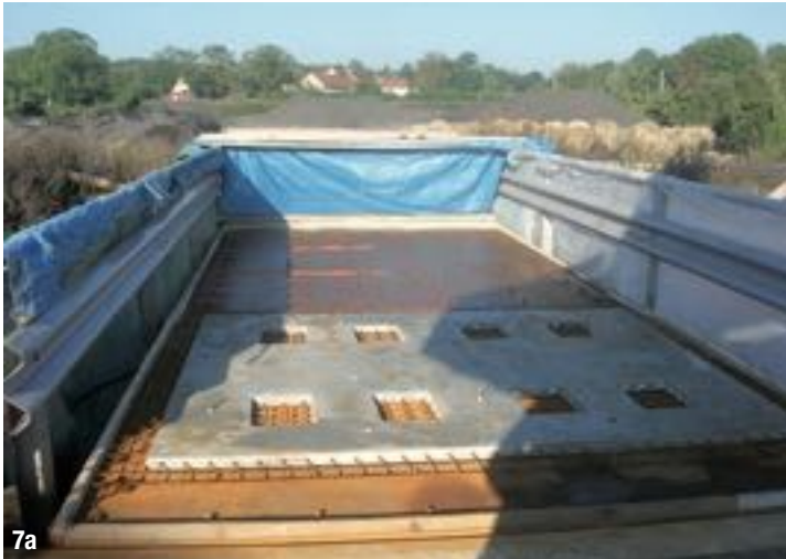
7a & 7b- Tablier VMD – Revêtement en BFUP. 8- Vue modèle 3D.
