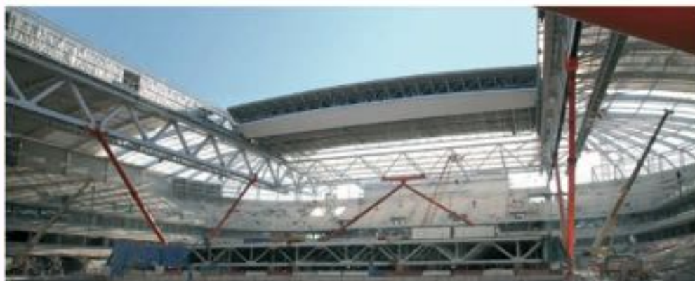
▲ Fondation Louis Vuitton pour la Création - Études d'exécution des verrières ▼ Grand stade de Lille Métropole - Méthode de construction et études d'exécution des charpentes
