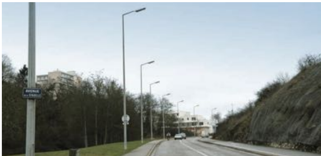
L'expérimentation des lampadaires à led prend place sur une route de transit à Talant (Côte-d'Or).
