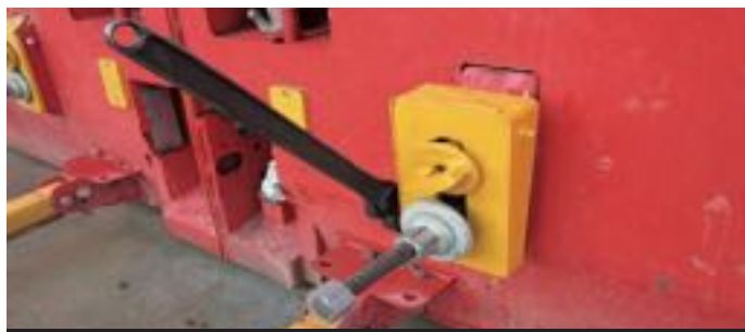
Un écrou latéral vient libérer les efforts sur la tige reliant les banches.
