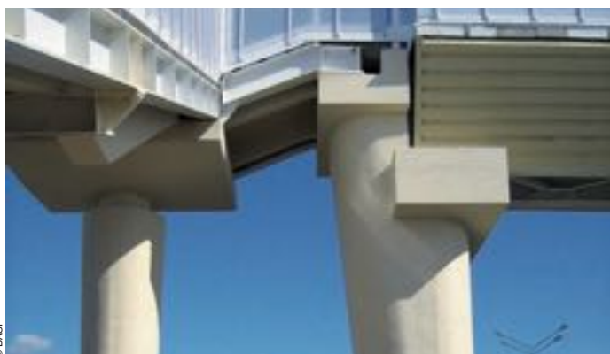
Ces revêtements en résines protègent le béton en environnement agressif.
