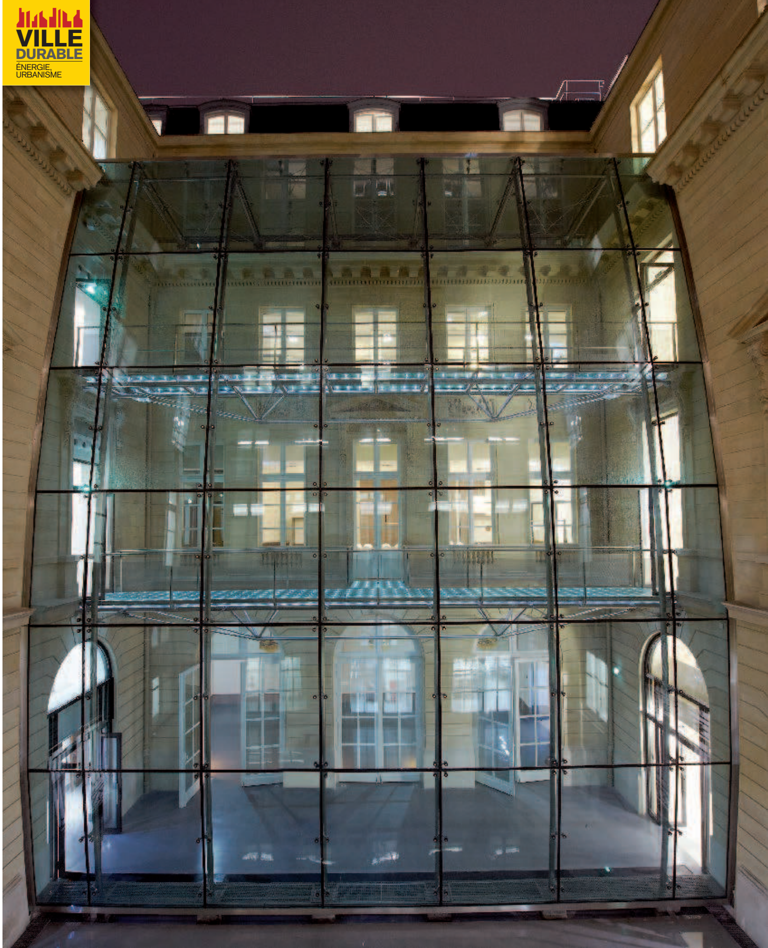
1- Galerie de deux passerelles longitudinales entièrement vitrée.
