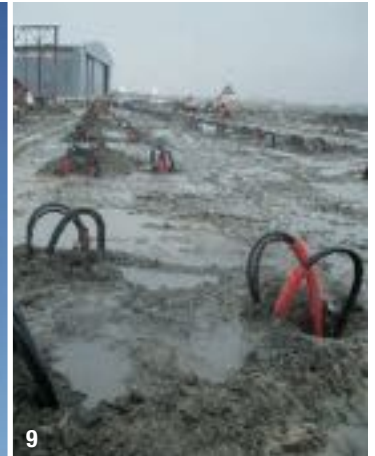
8 & 9- Installation de pieux géothermiques à l'usine EADS à Getafe (Espagne).
