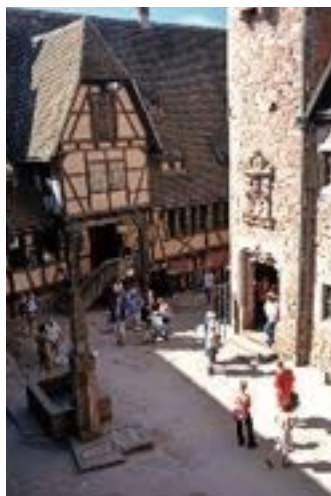
La Maison alsacienne a été construite à partir de 1904 sur un schéma où tous les composants de la structure sont solidaires, d'où la difficulté de sa remise d'aplomb.
