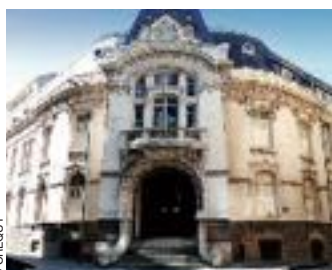
Dans le quartier du Crêt de Roc, la Condition des soies, où étaient stockées des balles de soie, abritera des logements et des bureaux après sa mise aux normes.
