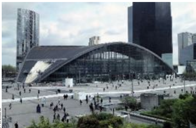
La voûte du Cnit, terminée en 1958, devait être étanchéifiée. Du coup, elle a été aussi isolée.
