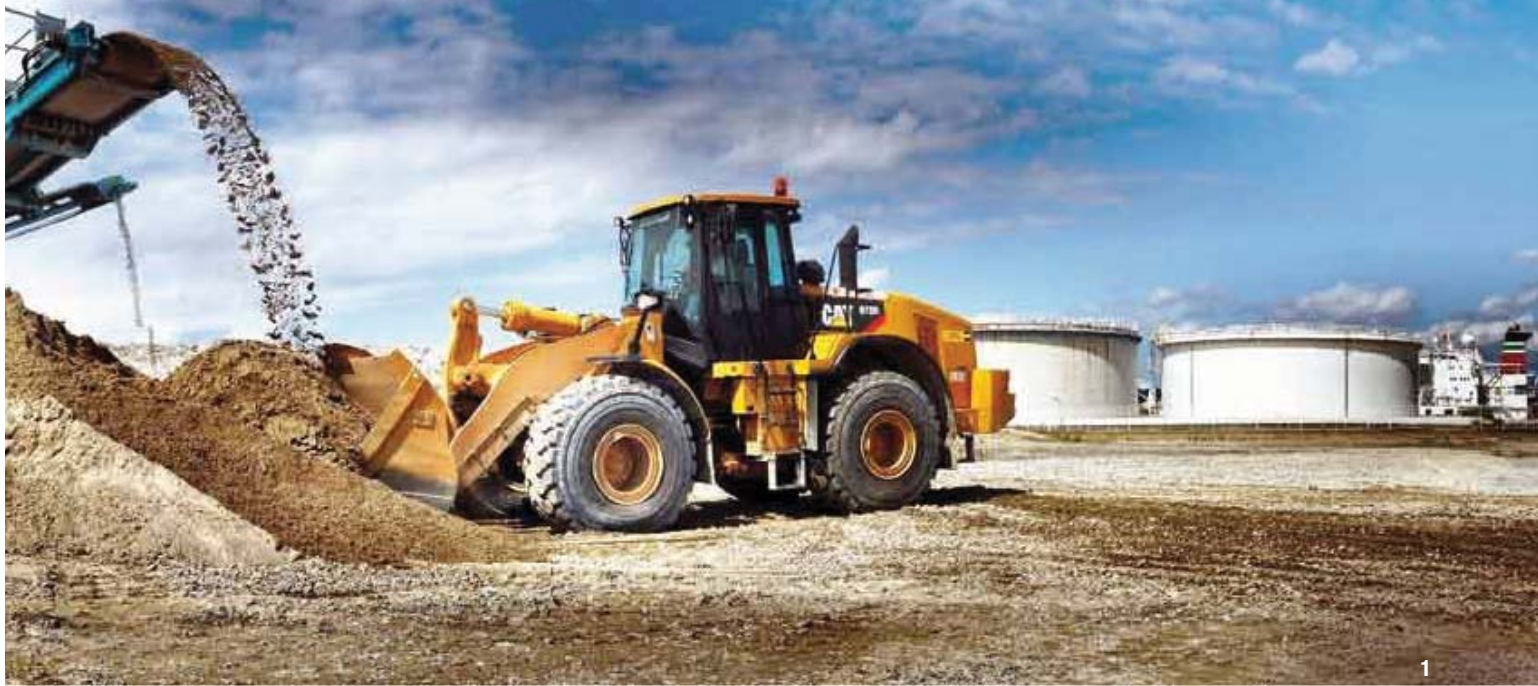
1- Élaboration des matériaux bruts par criblage. 2- Compacteur BW 226 en zone portuaire.
