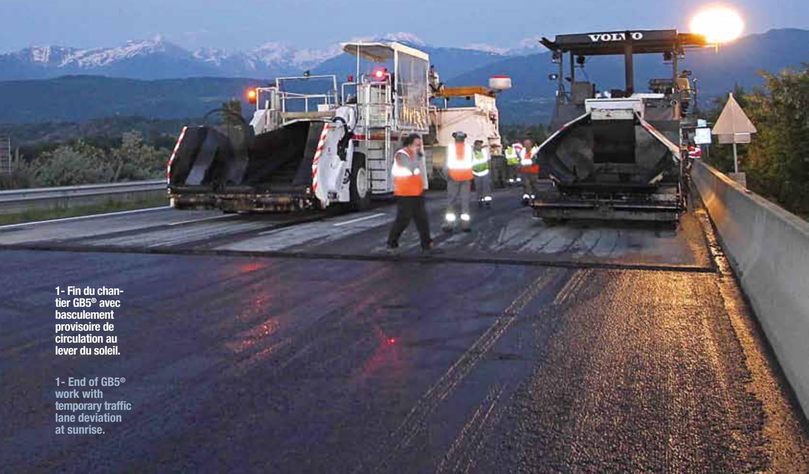
1- Fin du chantier GB5® avec basculement provisoire de circulation au lever du soleil.
