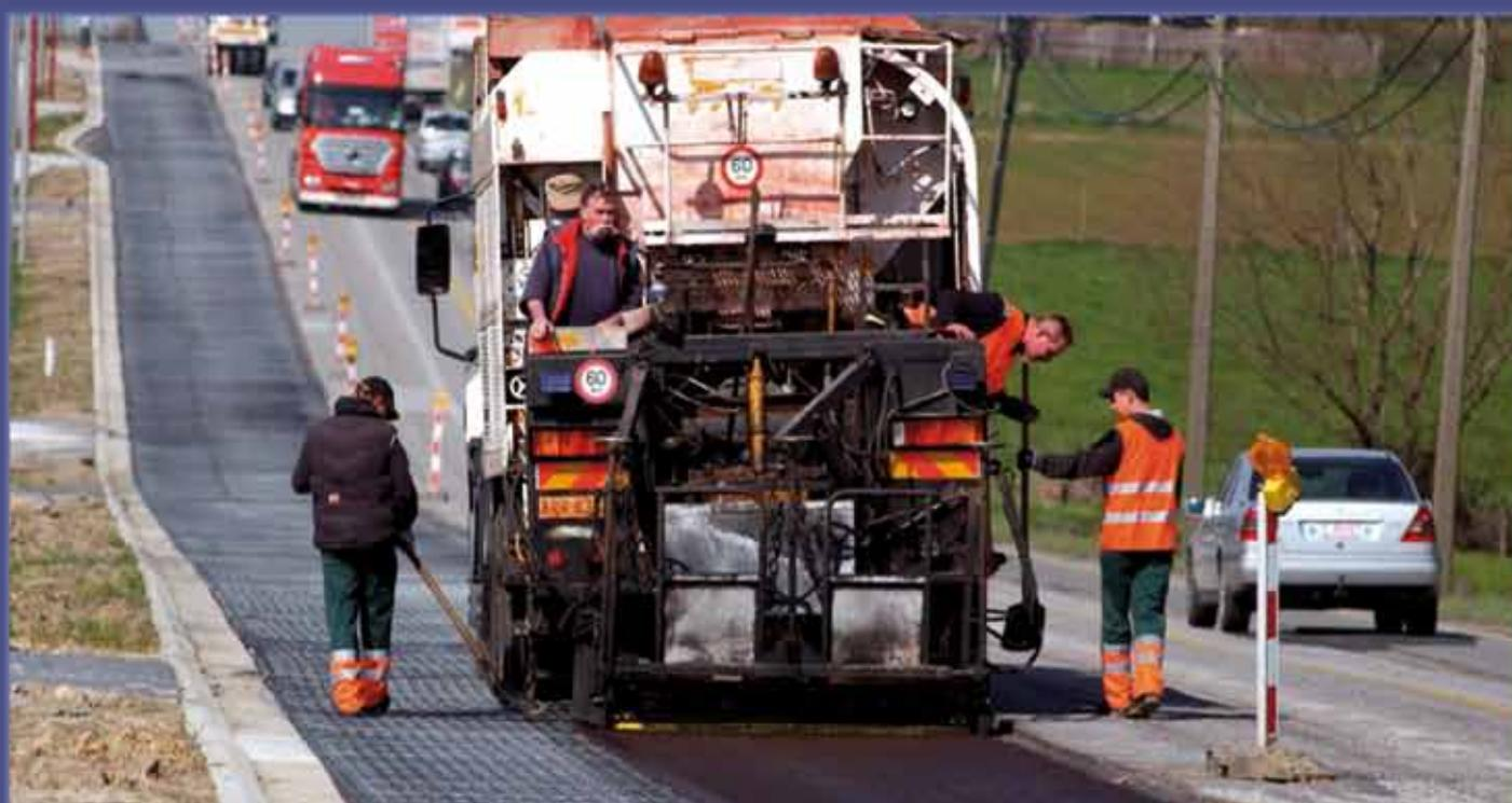
**Treillis d'armature avec un revêtement Bezinal<sup>®</sup> (Zn + Al)**
