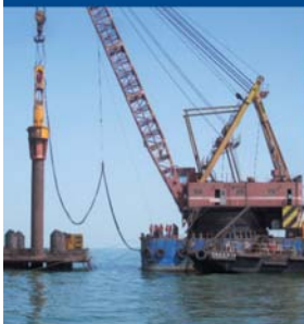
Essais dynamiques sur fondations > MAURITANIE
