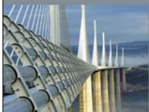
Viaduc de Millau
