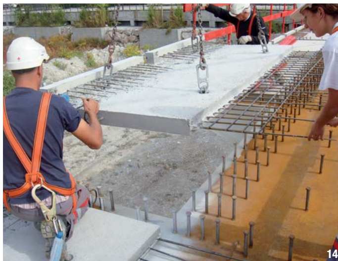
14- Pose des prédalles.
