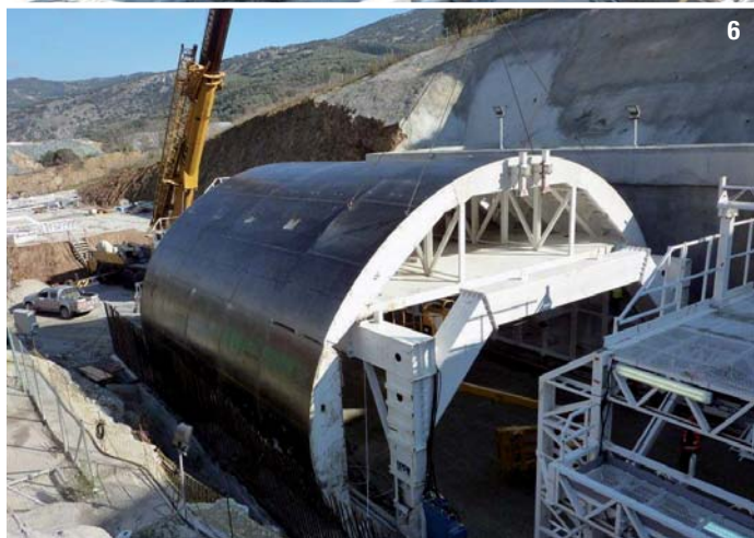
5 & 6- Tunnel de Maliakos (Grèce).
