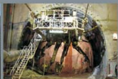
Tube Sud du tunnel de Toulon
