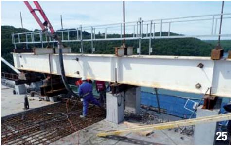
25- Charpente HEB 1000 pour le maintien de la zone de clavage.
