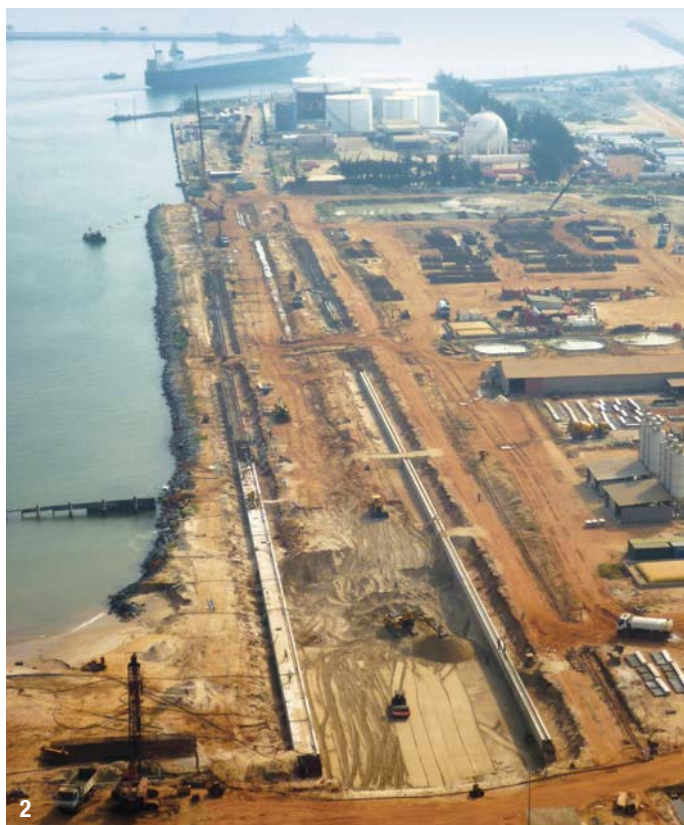
2- Vue d'ensemble du chantier.
