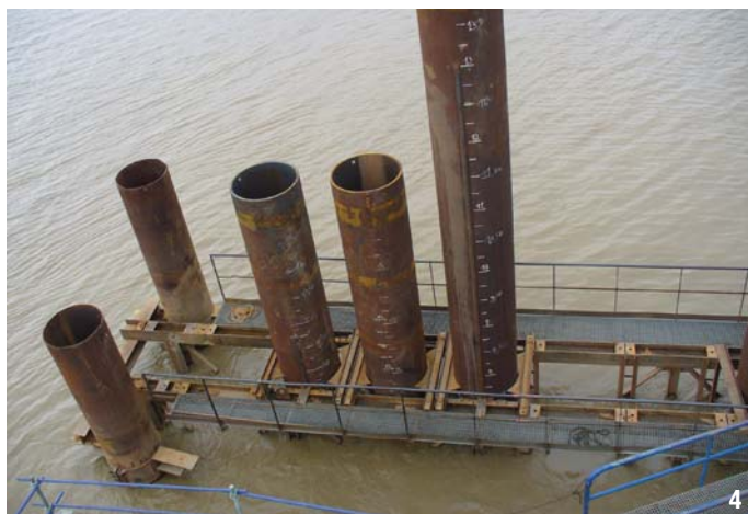
4- Faux pieux du rideau mixte. 5- Forage au trépan émulseur.
