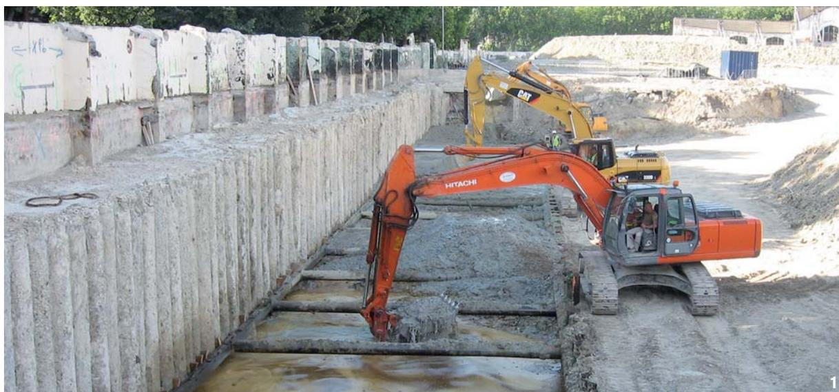
1- Extraction des matériaux pollués sous nappe - casier de palplanches et confortement par pieux séquentiels.
