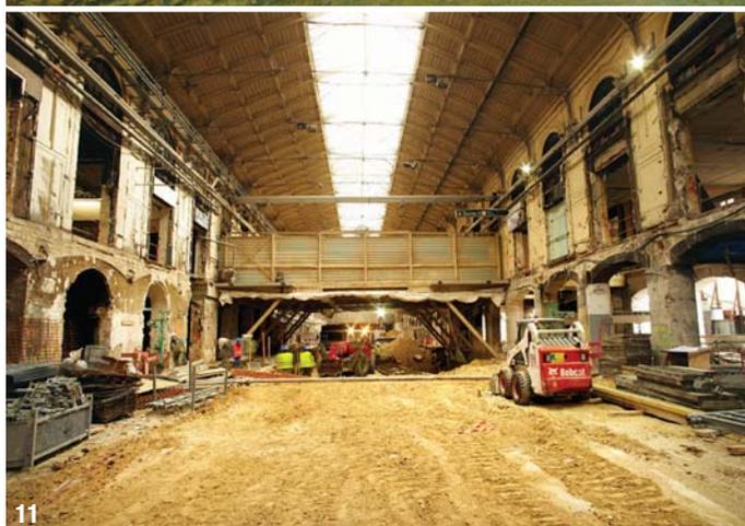
du bâtiment ancien quand il reposera sur les nouvelles installations, il est posé provisoirement sur des vérins, qui permettent à la future structure de récupérer l'intégralité des charges de l'existant.
