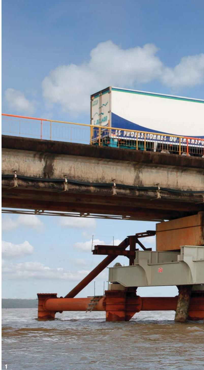
« LES ÉLÉMENTS DE STRUCTURE SONT RÉASSEMBLÉS SUR PLACE PAR BOULONNAGE, MIS À L’EAU ET TRANSPORTÉS PAR REMORQUAGE EN FLOTTAISON JUSQU’À LA PILE N° 13 DU PONT »
