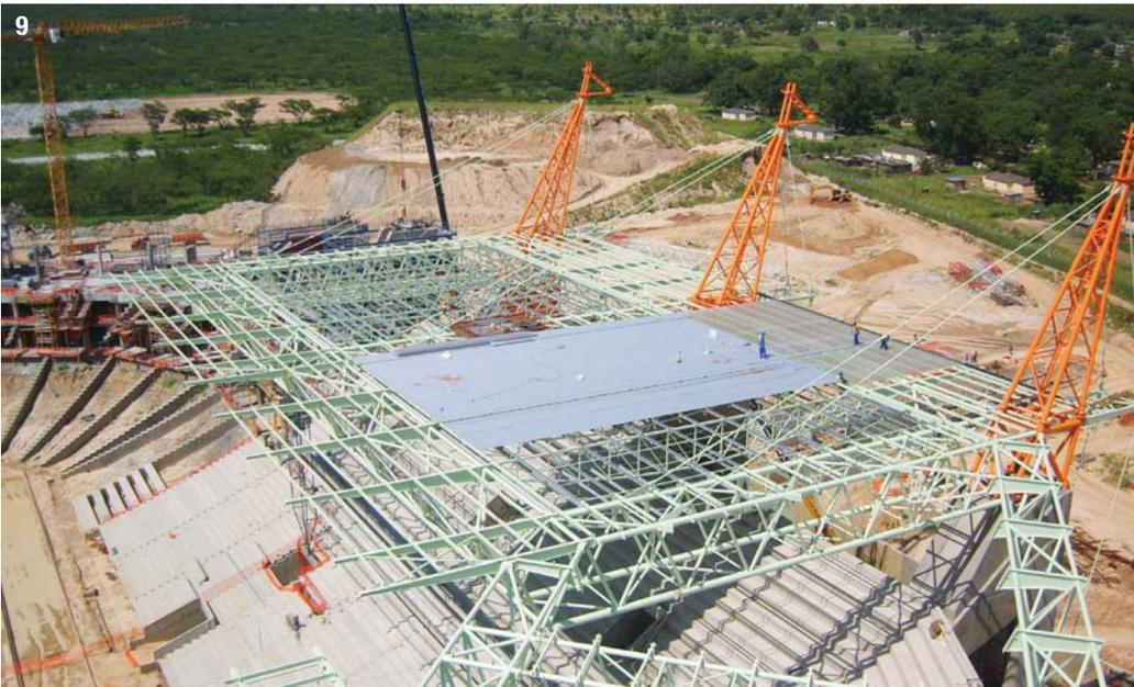
Cette structure béton est surplombée par une structure métallique culminant à 35 m (le cou et la tête des girafes). Outre l'aspect architectural, la structure métallique sert à reprendre le poids de la toiture en porte-à-faux par un système de haubans venant s'ancrer dans les poteaux béton ovales (photos 9 et 10).
