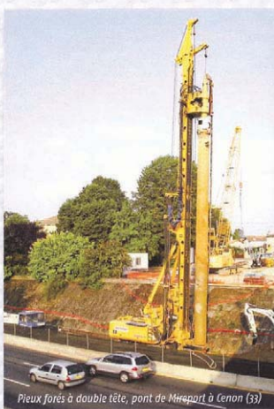
Pieux forés à double tête, pont de Mirapart à Lenon (33)
