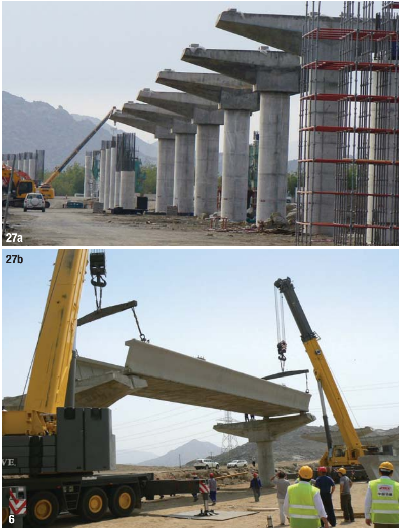
25a & 25b- Poutres préfabriquées des plates- formes. 26a & 26b- Éléments préfabriqués installés sur les chevêtres coulés en place. 27a & 27b- Phases de construction des travées.
