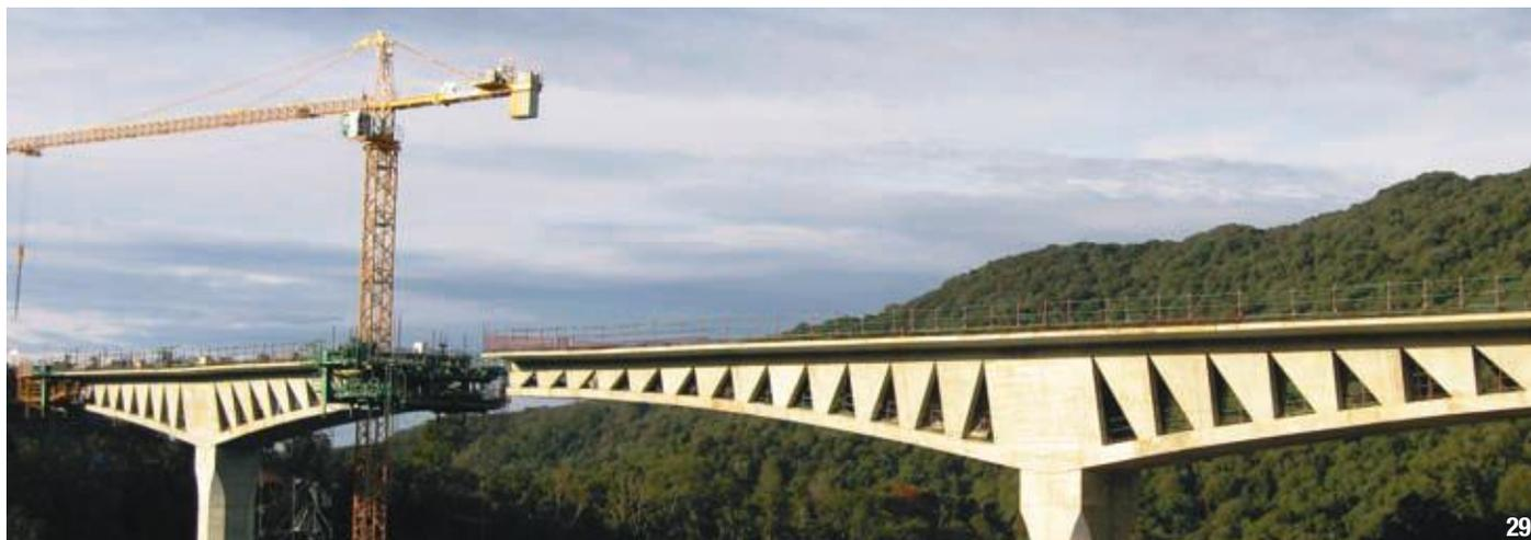
en tension des barres de précontrainte de premier lit (voussoir n-3) ; Les résistances avant décoffrage et mise en tension pour les différentes phases étaient contrôlées par matorométrie. 12 personnes étaient affectées à la réalisation des voussoirs de fléau, hors préfabrication des âmes.
