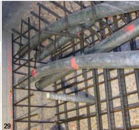
Le manque de documents de récolement sur le tablier aval de l'ouvrage ajoutait aux incertitudes habituellement rencontrées quant aux aléas de positionnement réel des armatures passives et actives. Il n'était pas envisageable d'endommager un câble de précontrainte et, dans la mesure du possible, il fallait éviter de couper les aciers passifs existants.
