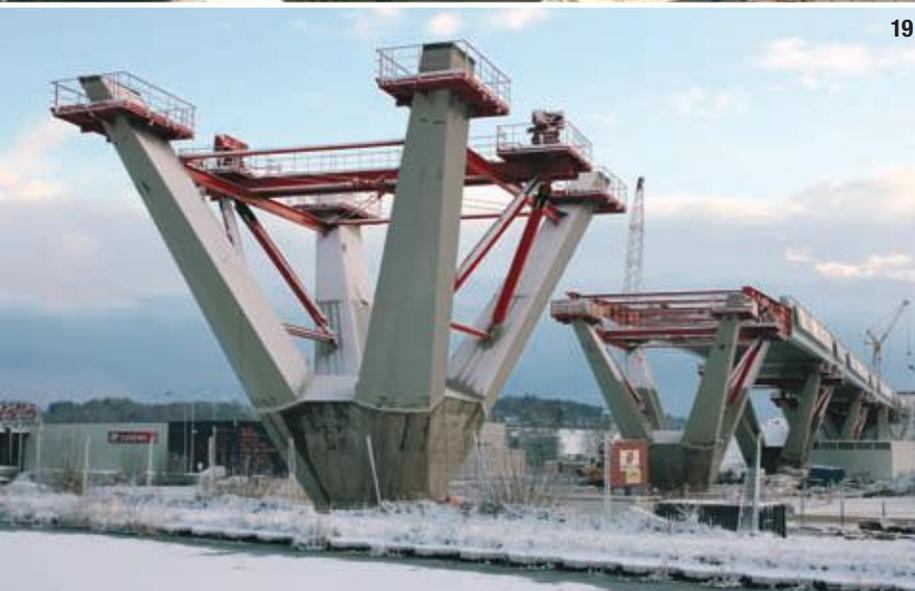
**17- Attelage provisoire des travées pour le lançage.**
