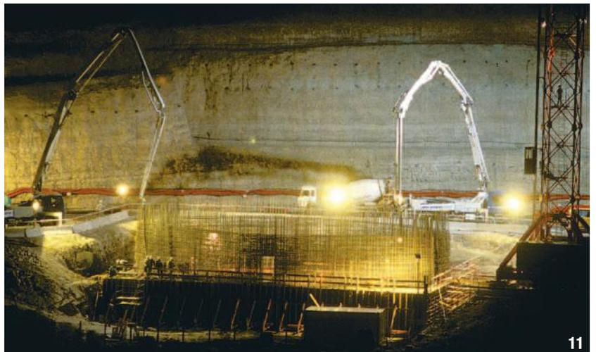
**11- Bétonnage de la semelle de la pile P2.**
