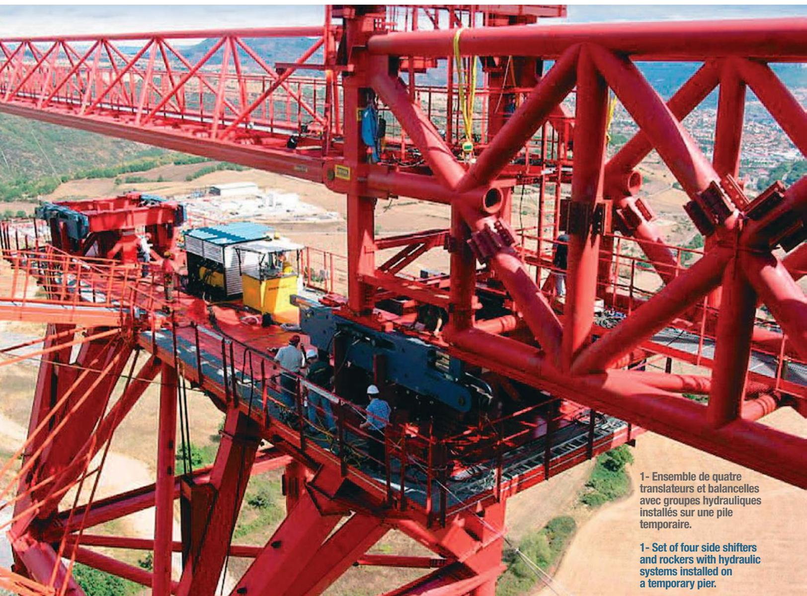
1- Ensemble de quatre translateurs et balancelles avec groupes hydrauliques installés sur une pile temporaire.
