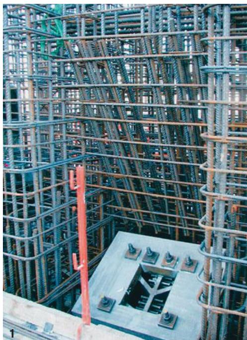
**1- Appui d'un chevêtre provisoire de pile.**
