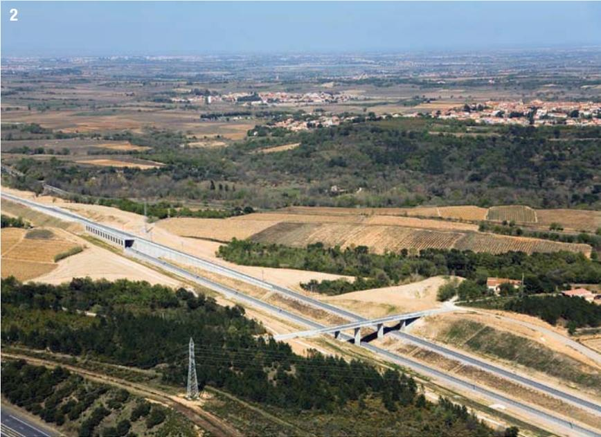
viaire proprement dite. En effet, le tracé en plan est conditionné par les très importants rayons de courbure liés à la grande vitesse. Quant au profil en long, il est lui aussi conditionné par les faibles pentes autorisées par l'activité fret de la ligne (LGV mixte). Les arbitrages faits par l'État par rapport aux habitations et aux enjeux environnementaux se trouvent donc rapidement confirmés dans leur ensemble.
