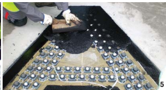
4 et 5- Coulage d'asphalte à chaud (220 °C) autour de modules lumineux.
