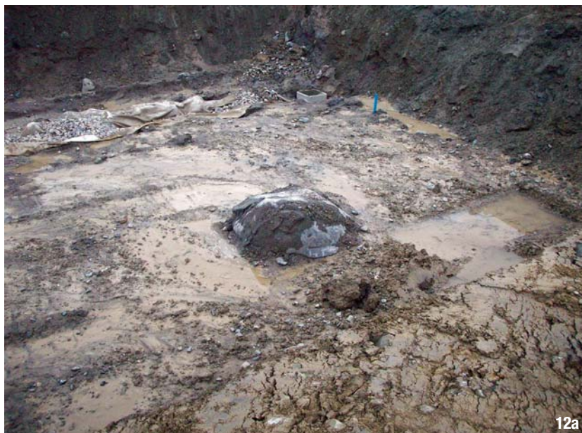
12a et 12b- Exemple de blocs mis à jour lors des travaux de terrassement.
