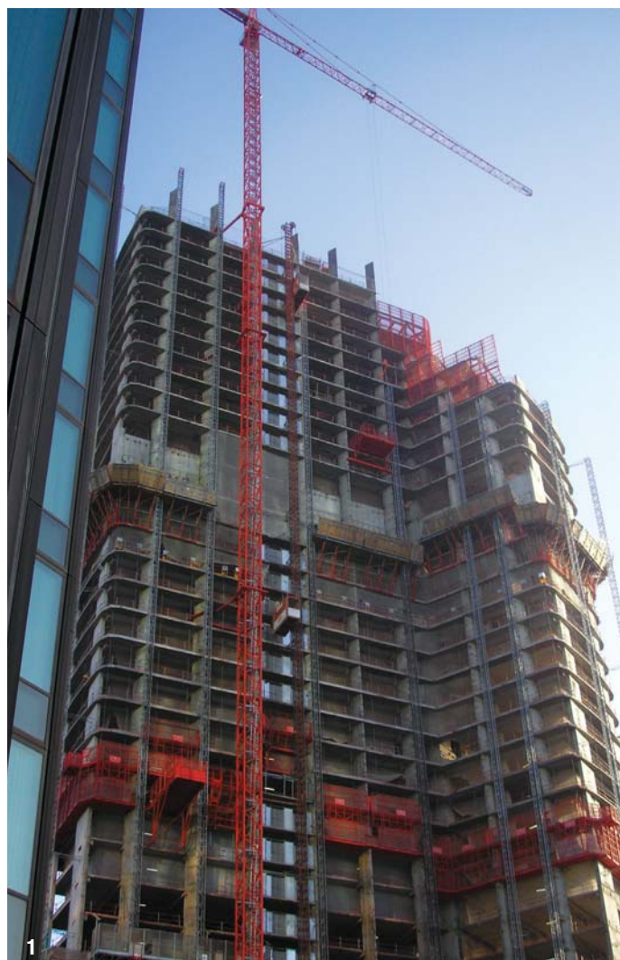
1- Travaux de rehausse de la tour CB 31.
