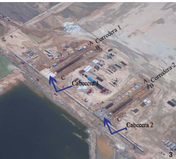
3- Vue aérienne du chantier, de ses 300 m de front de mer et de ses deux Correderas (1 et 2), destinés à la fabrication et au lancement de plates-formes.
