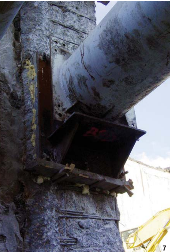
7- Mise en compression des butons.
